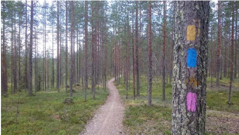
Kuva x. Hyvin onnistunutta kuivan maaston kulutuskestävöintiä Syötteellä. Kuva: Pekka Tahkola
