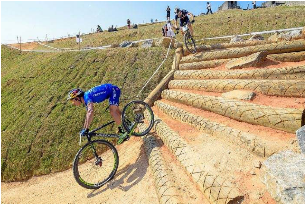
Kuva x. Jyrkät puunrunkoportaavat Rion olympiaradalla. Sarkkirannan reitille ehdotetut portaavat ovat huomattavasti loivemmat (askelväli vaakatasossa n. 3-4 metriä), harvemmat ja turvallisemmat. Kuva: Stuart Kenny
