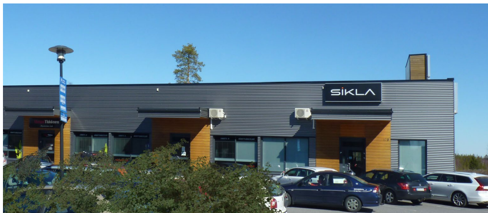
Kuva 6. Esimerkki pihan puolen julkisivun jäsentelystä. Päämateriaalina siististi detaljoitu harmaa aaltopelti. Sisäänkäyntien korostuksena kuultokäsitelty lautaverhouskenttä. Zateeliintie 17.
