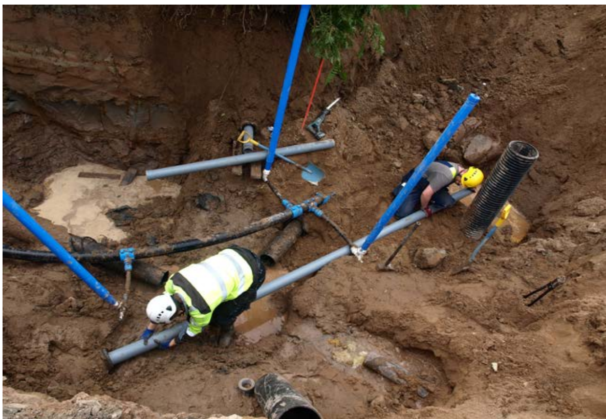
Kuva 11. Kempeleen Vesihuolto Oy saneeraa. Kempeleen Vesihuolto Oy:n kuva-arkisto.
