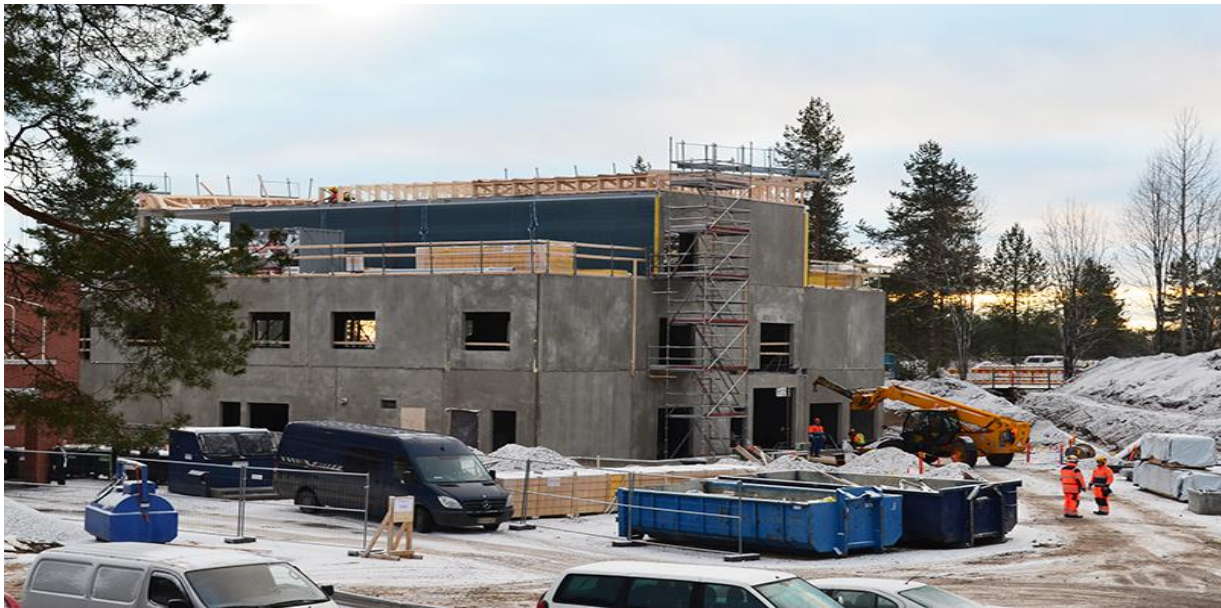
Kuva 6. Kempeleen terveyskeskuksen uudisosan rakennustyöt
