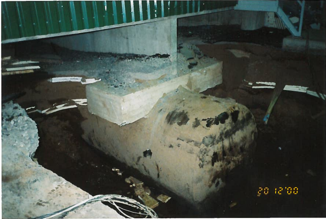
Kuva 1. Perustuksen alla sijaitseva öljysäiliö
