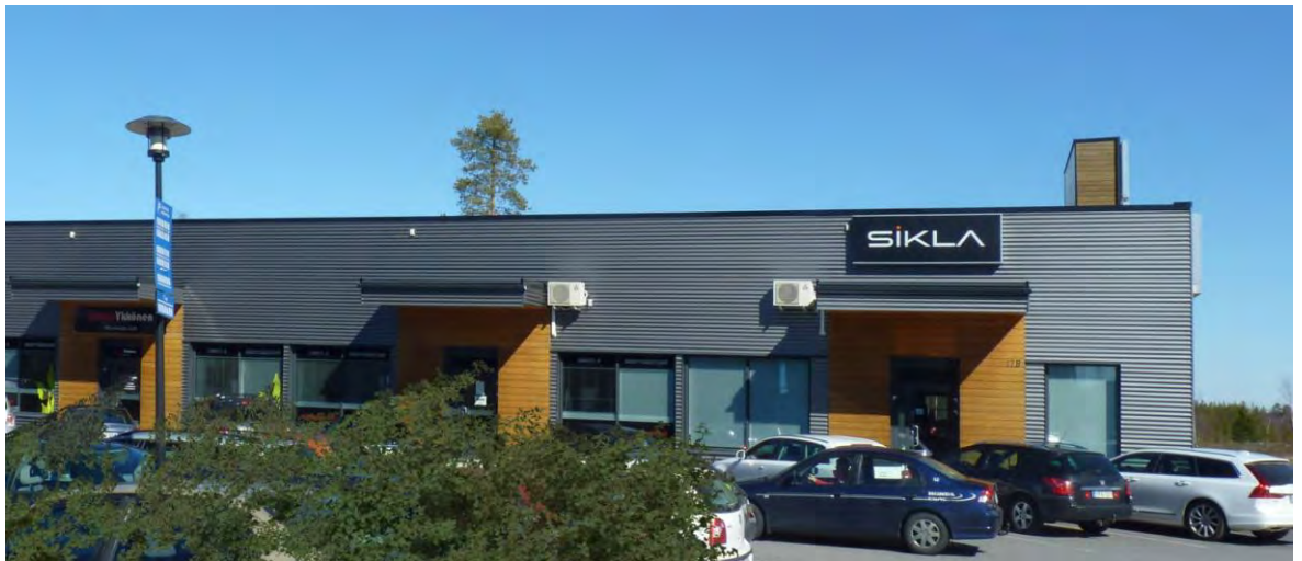
Kuva 4. Esimerkki pihan puolen julkisivun jäsentelystä. Päämateriaalina siististi detaljoitu harmaa aaltopelti. Sisäänkäyntien korostuksena kuultokäsitelty lautaverhouskenttä. Zatelliintie 17.
