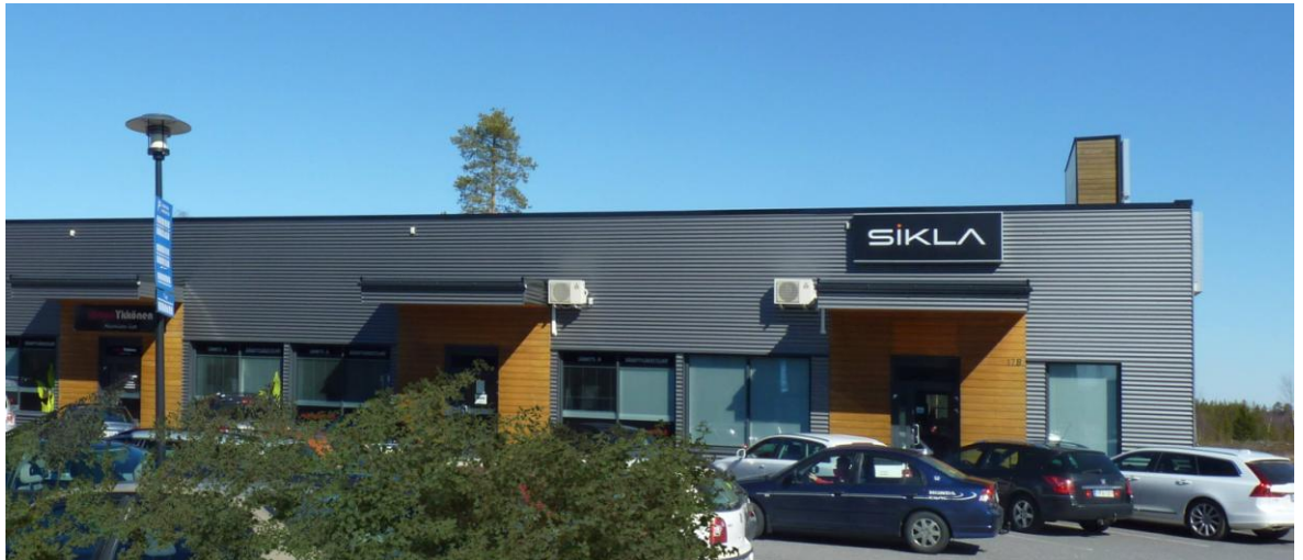
Kuva 4. Esimerkki pihan puolen julkisivun jäsentelystä. Päämateriaalina siististi detaljoitu harmaa aaltopelti. Sisäänkäyntien korostuksena kuultokäsitelty lautaverhouskenttä. Zatelliitintie 17.
