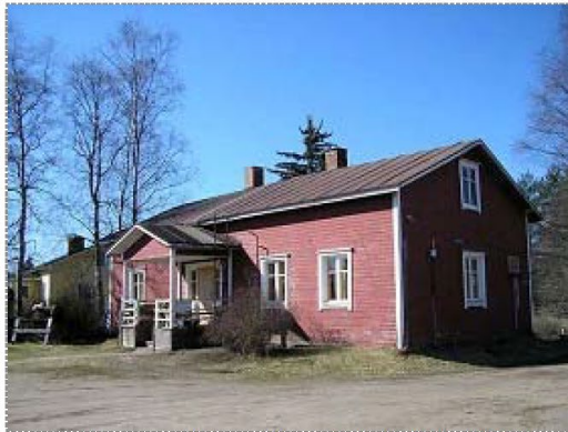
Asuinrakennus (Kuva: Kirsi Schali 12.5. 2005)
