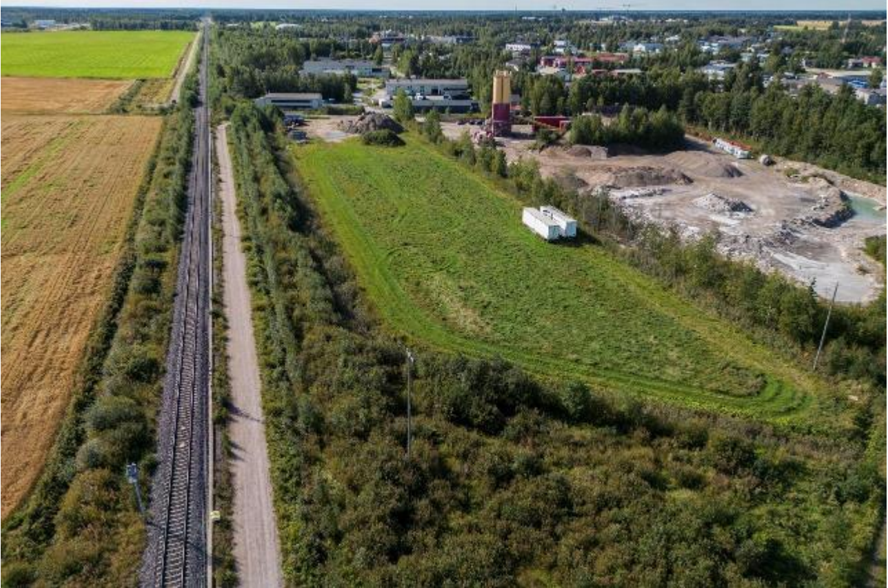
Kuva 29(0). Ilmakuva radan suuntaisesti. Suluissa oleva kirjain viittaa kuvan 17 kuvan ottopaikkaan.
