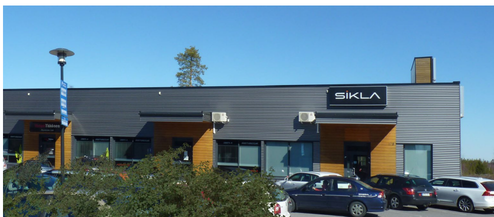
Kuva 4. Esimerkki pihan puolen julkisivun jäsentelystä. Päämateriaalina siististi detaloitu harmaa aaltopelti. Sisäänkäyntien korostuksena kuultokäsitelty lautaverhouskenttä. Zatelliitintie 17.
