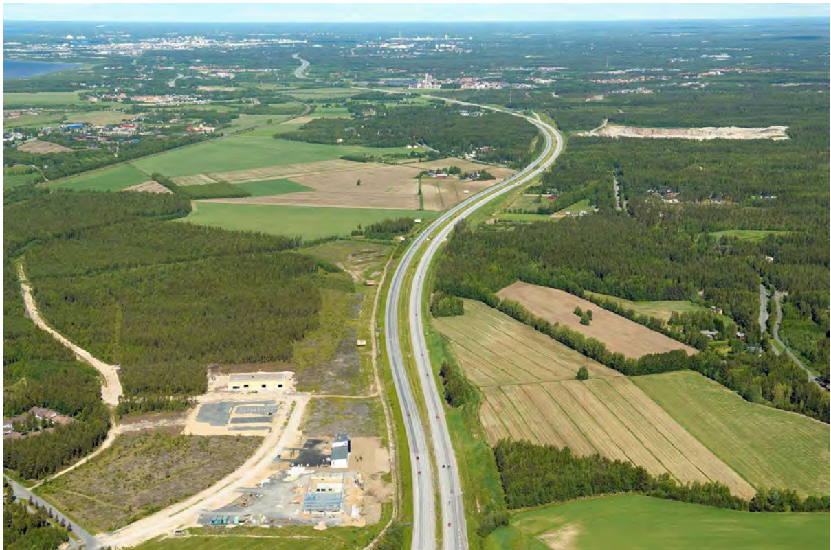
Kuva 4. Ristisuon keskeneräistä ympäristöä. Ympäristökuva tulee hoitaa rakentamisen myötä.
