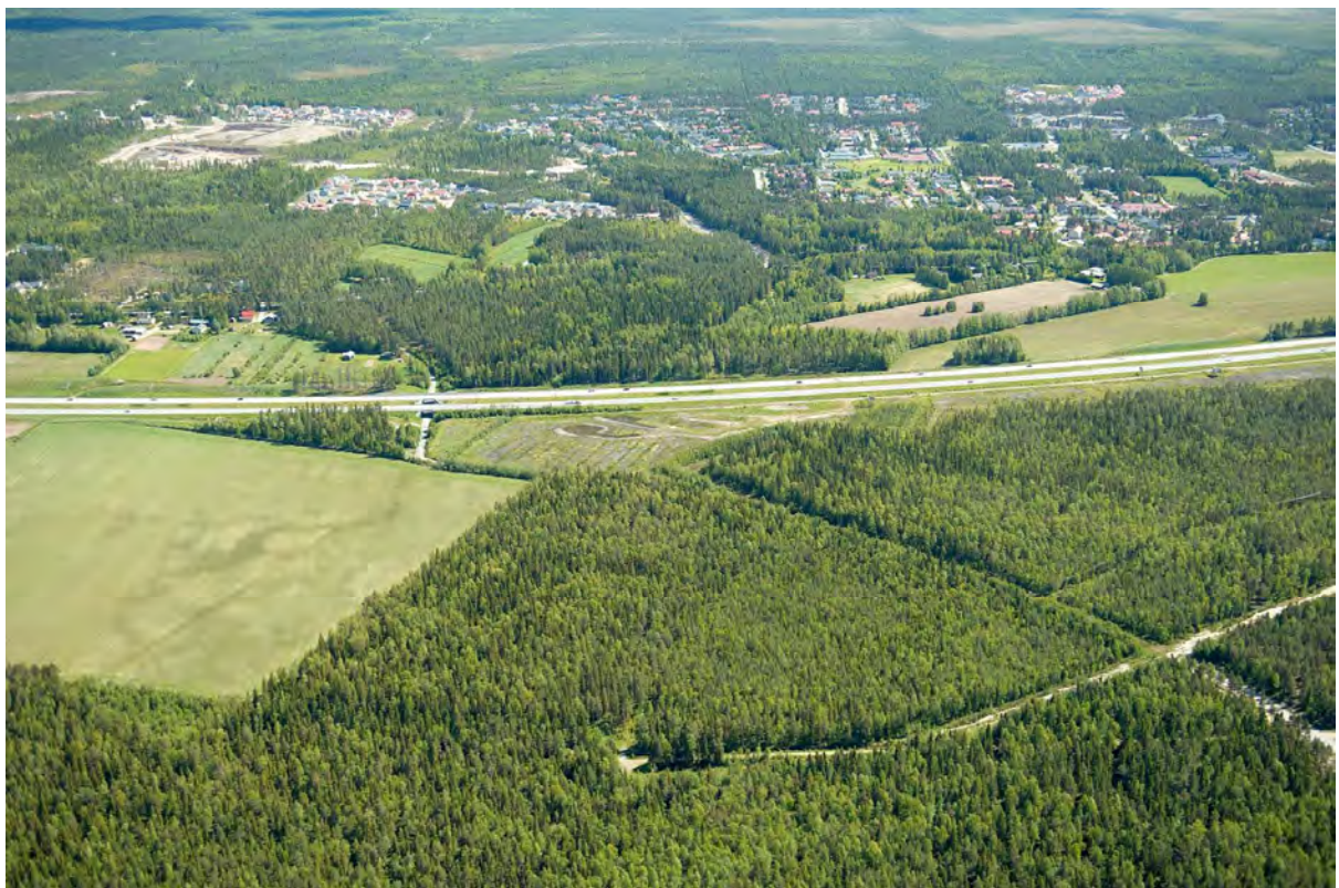
Kuva 2. Ristisuon rakentaminen on aloitettu katuverkon rakentamisella.
