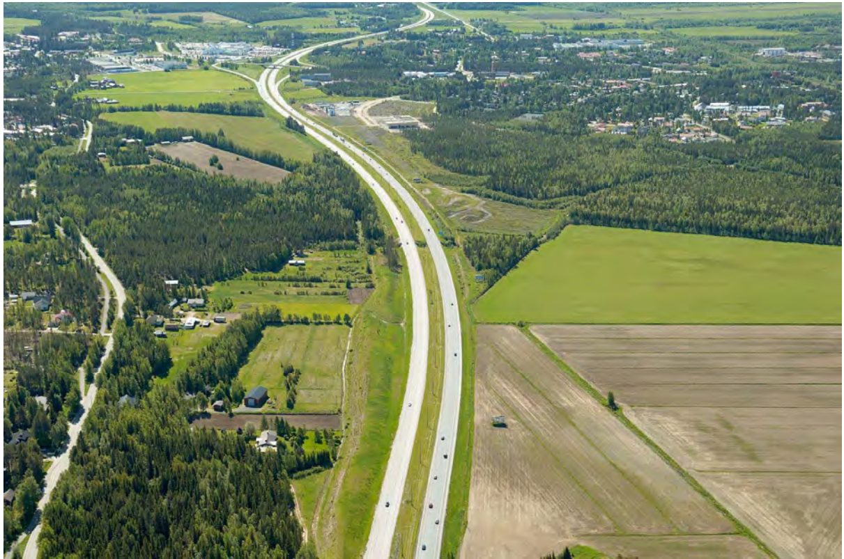
Kuva 1. Pohjantielle avautuva paikallisesti merkittävä kulttuurimaisema Ristisuon puolella
