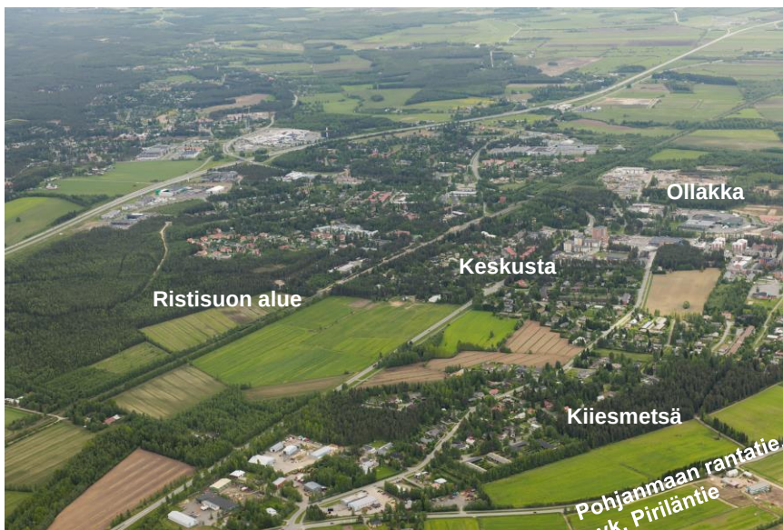
Kempeleen keskusta lähiympäristöineen pohjoisesta katsottuna.
