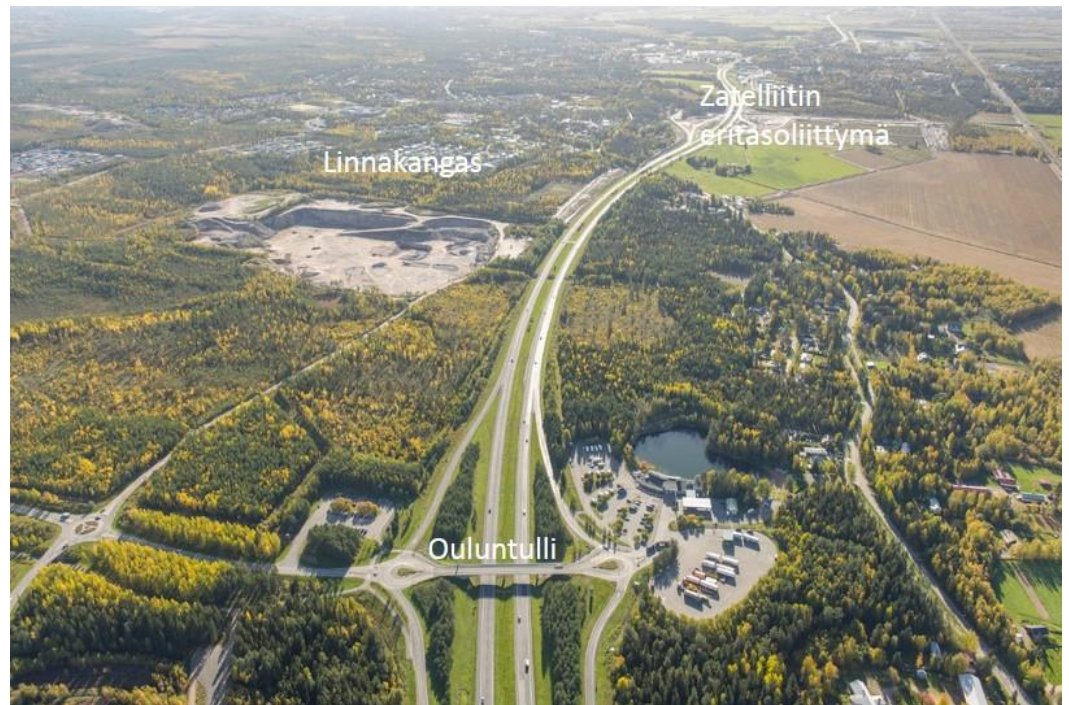
Viistoilmakuva Ouluntullista kohti etelää.
