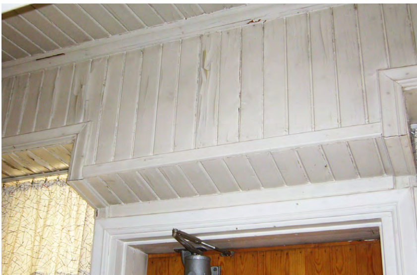
Länsipäädyn sisäkuistin listoitukset ovat samaa mallia kuin johtajan asunnon toisen kerroksen makuuhuoneiden listat.
