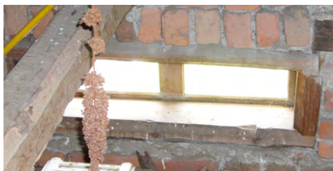
2-ruutuinen haukkaikkuna sisältä.
