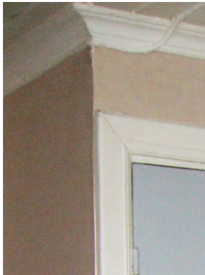
Kattolista johtajan asunnon toisen kerroksen makuuhuoneissa.
