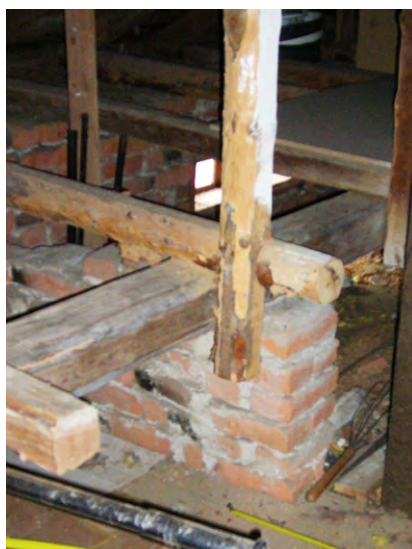
Kuva 62. Osa väliseinistä on muurattu, ja ne nousevat ullakolle asti kannattamaan vesikaton rakennetta.
