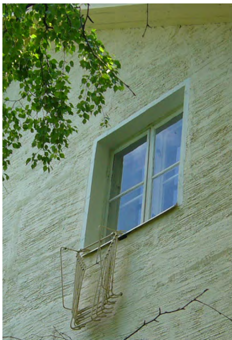
4-ruutuinen ikkuna ulkoa.
