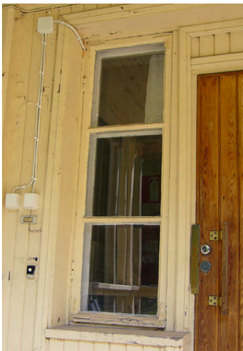
3-ruutuinen ikkuna ulkoa.
