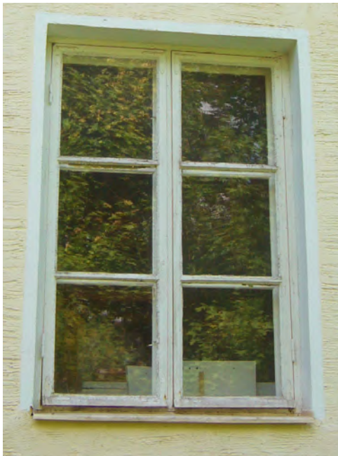
6-ruutuinen ikkuna ulkoa.
