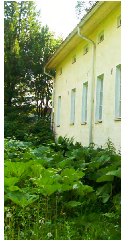
Kuva 79. Ryhmä 1 Villiintynyt Ruttojuuri valtaa rakennuksen takapihaa.
