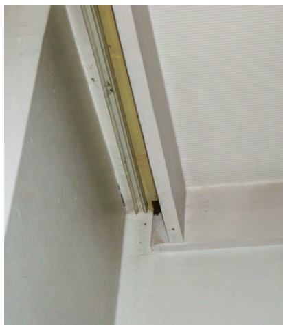
Kuva 66. 1970-luvun korjauksessa uusittu kattolista. Kattolistan liitoskohta verholautaan.
