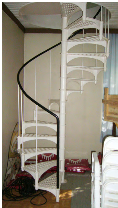
Kuva 38. Asuntolanhoitajan olohuoneessa on 1970-luvun korjaustöissä asennettu Högforsin metallikierreportas nro 7.
