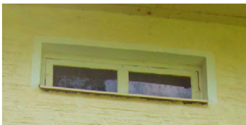
2-ruutuinen haukkaikkuna ulkoa.
