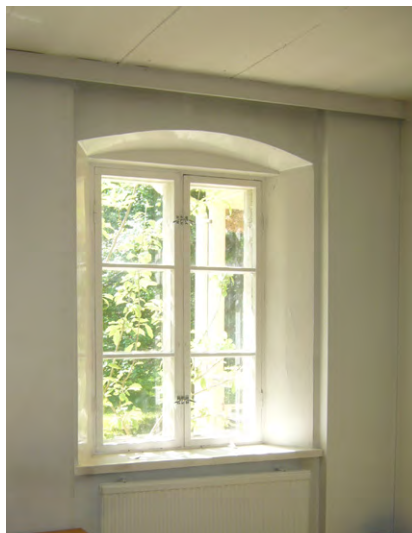
Kuva 70. Ensimmäisen kerroksen ikkunoiden sisäpuoli.
