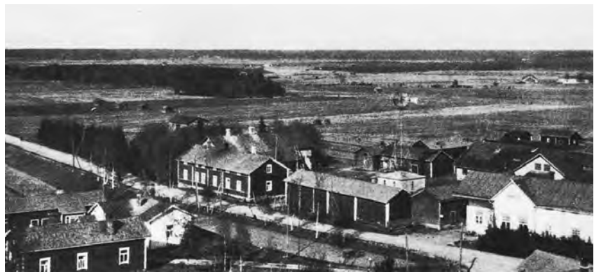
Kuva 21. Pirilä kirkonmäeltä kuvattuna 1920-luvulla. Viereisen sivun kuvaan verrattuna kaupparakennusta on laajennettu, sekä pitkä piharakennus ja navetta rakennettu. Keskellä pihaa näkyy neliön mallinen pumppuhuone.
