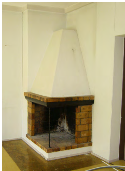
Kuva 72. Johtajan asunnon takka 1900-luvun puolivälistä.
