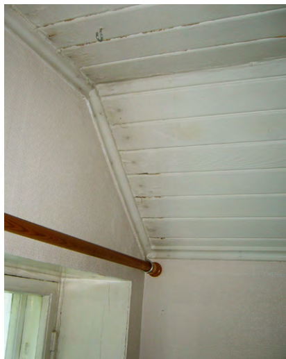
Kuva 65. Paneelikatto ja kaareva kattolista apulaisjohtajan asunnossa.
