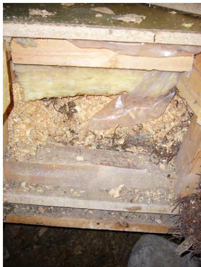
Kuva 57. Aukaistussa alapohjassa näkyy alkuperäistä rakennetta ja 1970-luvun korjaustöiden lisäykset.
