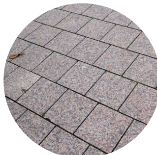
kiveys, paikalta louhittu kivi
