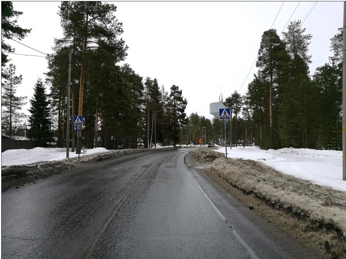
Kuva 5. Niittyrannantien ylitys Oulun seudun ammattiopiston kohdalla. Suojatien näkyvyyttä tulee parantaa.
