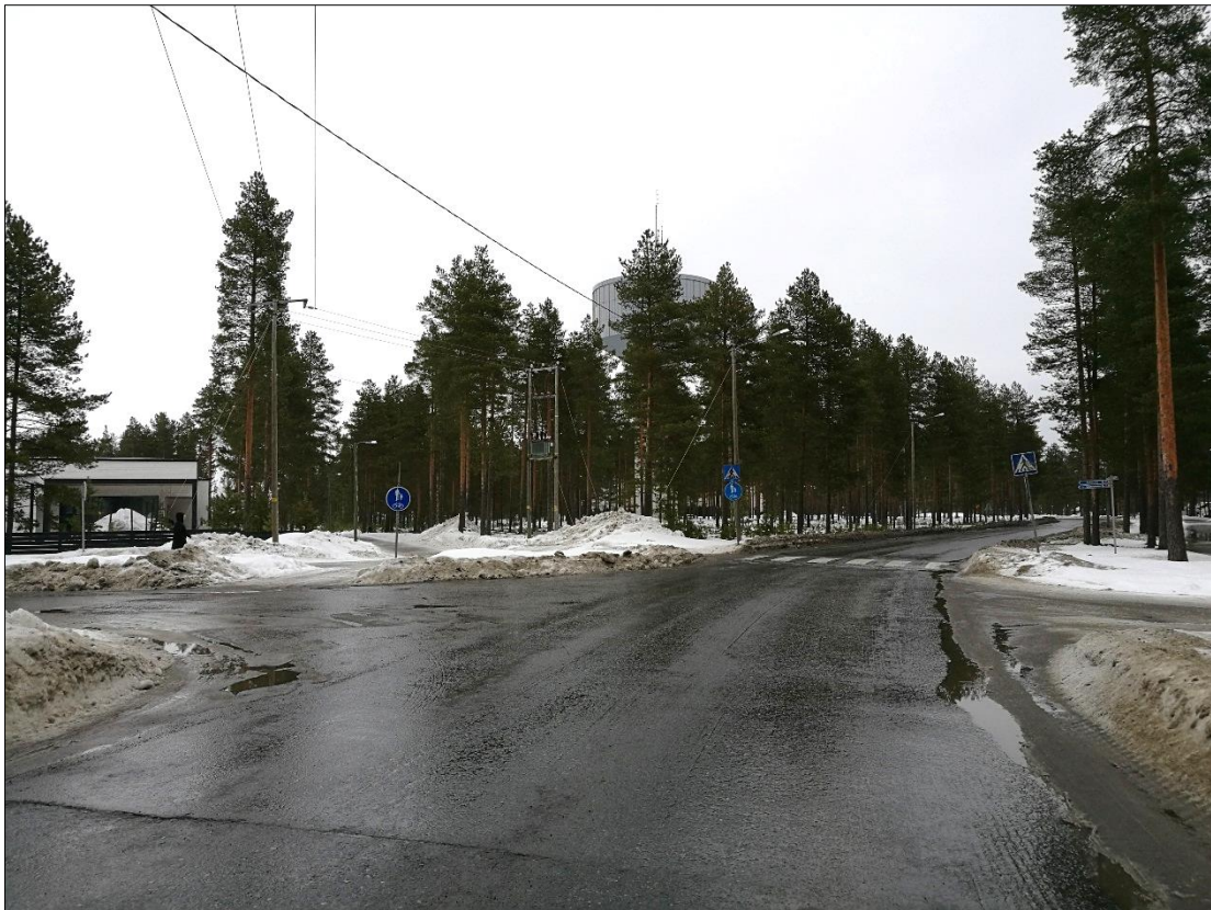
Kuva 4. Niittyrannantien ja Sarkkirannantien liittymä. Sivusuunnalle tarve suojatiesaarekkeelle ja pääsuunnan suojatien näkyvyyttä kannattaa parantaa.
