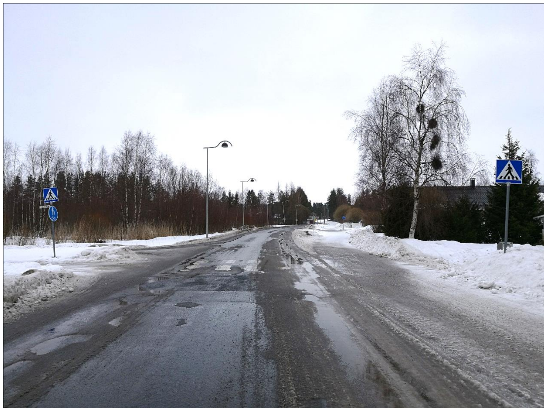
Kuva 8. Niittyrannantien ja Kuovitien liittymä. Pääsuunnan suojatien näkyvyyttä pitää parantaa.
