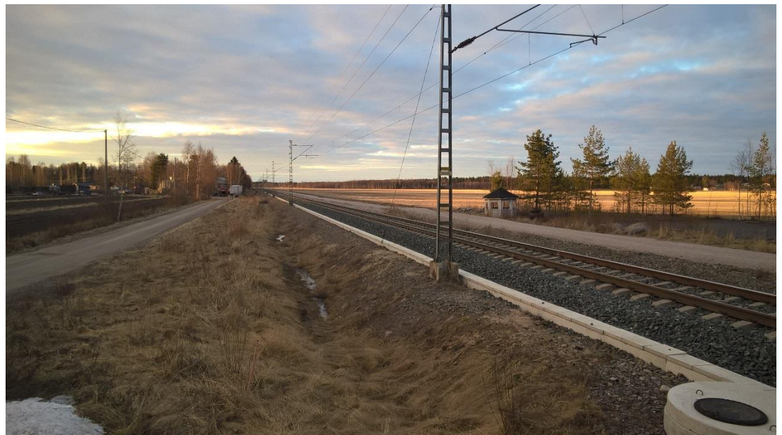
Kuva 4.2. Rata kuvattuna mittauspisteiden 3-4 kohdalta pohjoiseen.
