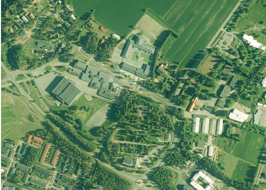
Ilmakuvassa kirkonmäki erottuu koulurakennusten ympäröimänä metsäisenä kokonaisuutena. Sen pohjoispuolella sijaitsevat laajana kokonaisuutena Kirkonkylän koulun ja Kempeleen lukion rakennukset piha-alueineen. Vanha Vihiluodontie kulkee koulun alueen läpi kevyen liikenteen väylänä, vanhan tielinjauksen kohdalla on koulun alueen molemmin puolin pysäköintialueet. (Kuva MML Kart-tapaikka).
