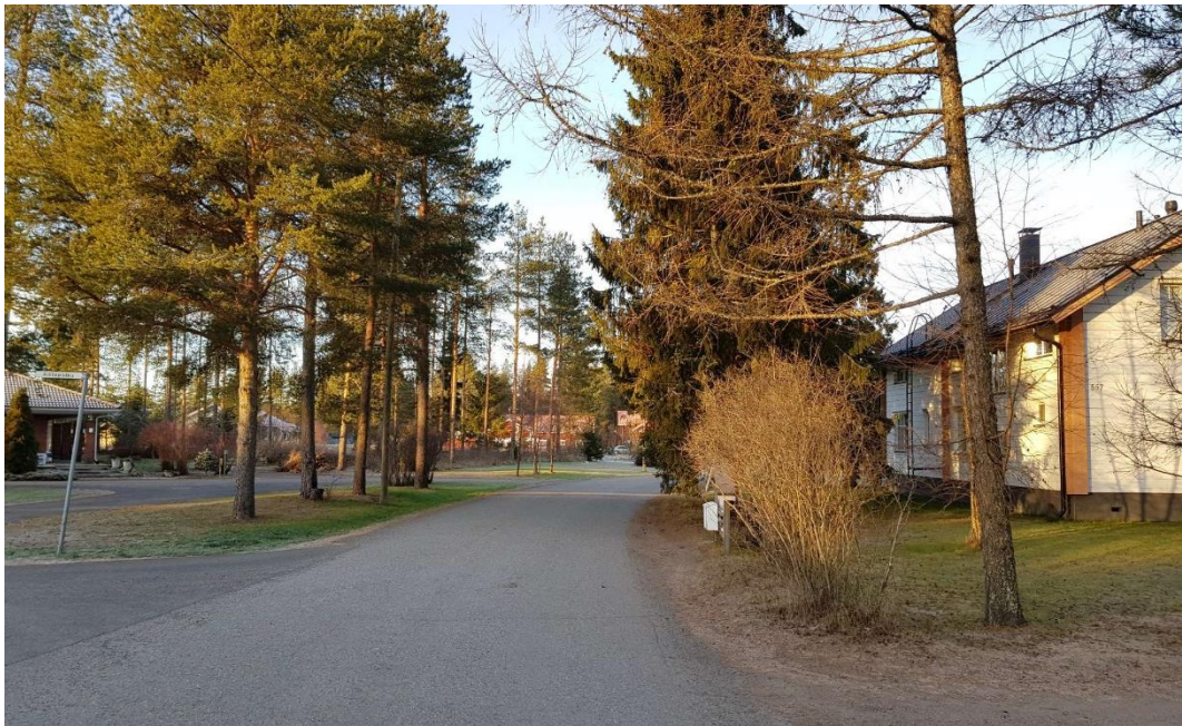
Koulun alueen luoteispuolella Vihiluodontien varressa on sekä vanhaa että uudempaa rakennuskantaa. Rakennetun kulttuuriympäristön yleisilme on kerroksellinen. Vanhat arvorakennukset erottuvat miljöössä omaa aikaansa edustavana, ympäristöä rikastuttavana kerroksena.
