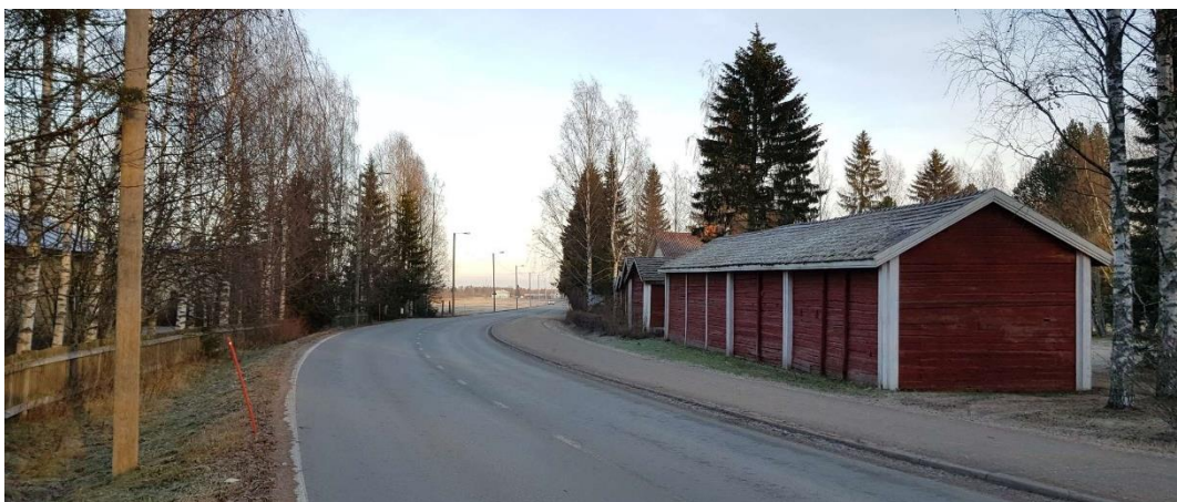
Pirilän punaisiksi maalatut talousrakennukset erottuvat maamerkkirakennuksina tiemaisemassa.
