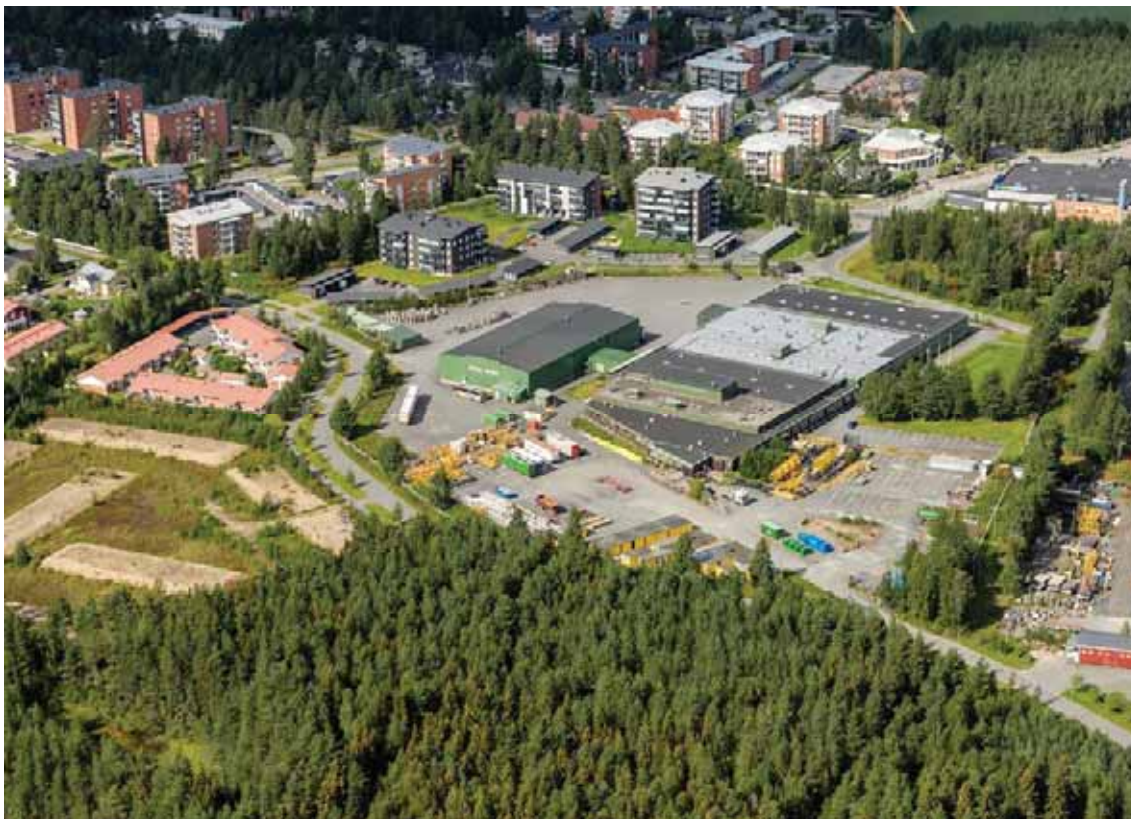
Kuva 49. Suurempi teollisuushalli ja siihen liittyvä jalkapallohalli sijaitsevat keskeisellä paikalla suunnittelualuetta. Kunta on ostanut teollisuushallit tontteineen. Kuvan vasemmassa laidassa näkyvät korttelin 6008 (AKR, asuinkerrostalojen ja rivitalojen korttelialue) painopenkat. Kuvan etualalla näkyy metsäistä virkistysaluetta (kuva: Kempeleen kunta).
