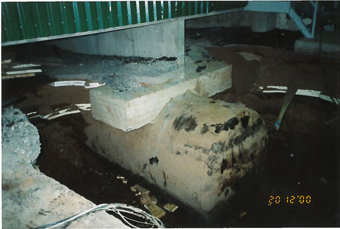
Kuva 1. Perustuksen alla sijaitseva öljysäiliö
