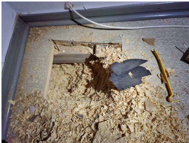
Kuva 12. Asuinrakennuksen välipohjan tervapaperi on kutterin alla
