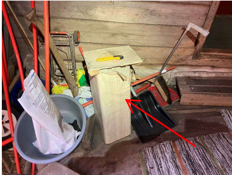
Kuva 7. Irtonainen Minerit-kanava
