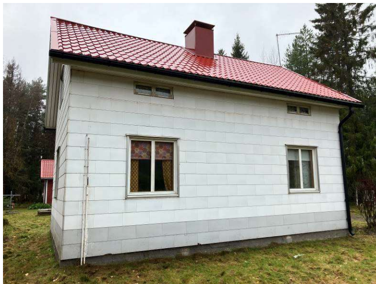
Kuva 1. Julkisivun asbestisementtilevyä
