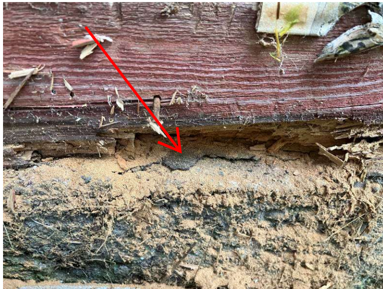
Kuva 4. Sokkelin päällä oleva bitumihuopa
