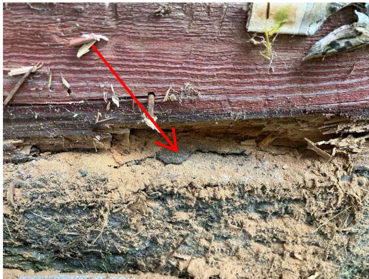
Kuva 10. Asuinrakennuksen sokkelin pinnan bitumihuopa
