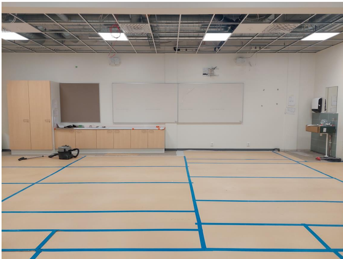
Kuva 10. 2.krs B-lohkolla mallihuoneen teko edistyy. Varusteita ja AV-laitteita asennettu.
