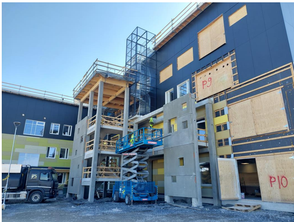
Kuva 4. Rakennuksen pohjoispuolella ensimmäisen katoksen puurakenteet tehty ja kierreporras asennettu.
