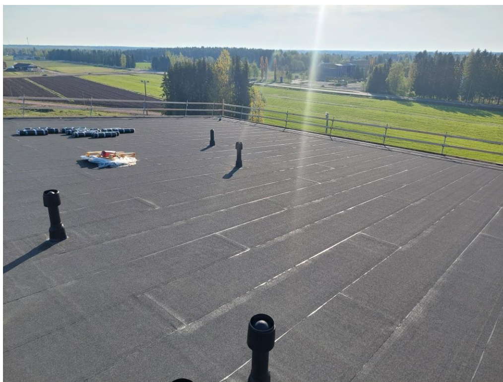
Kuva 5. Vesikaton pintakermi on asennettu 3.krs katolle.
