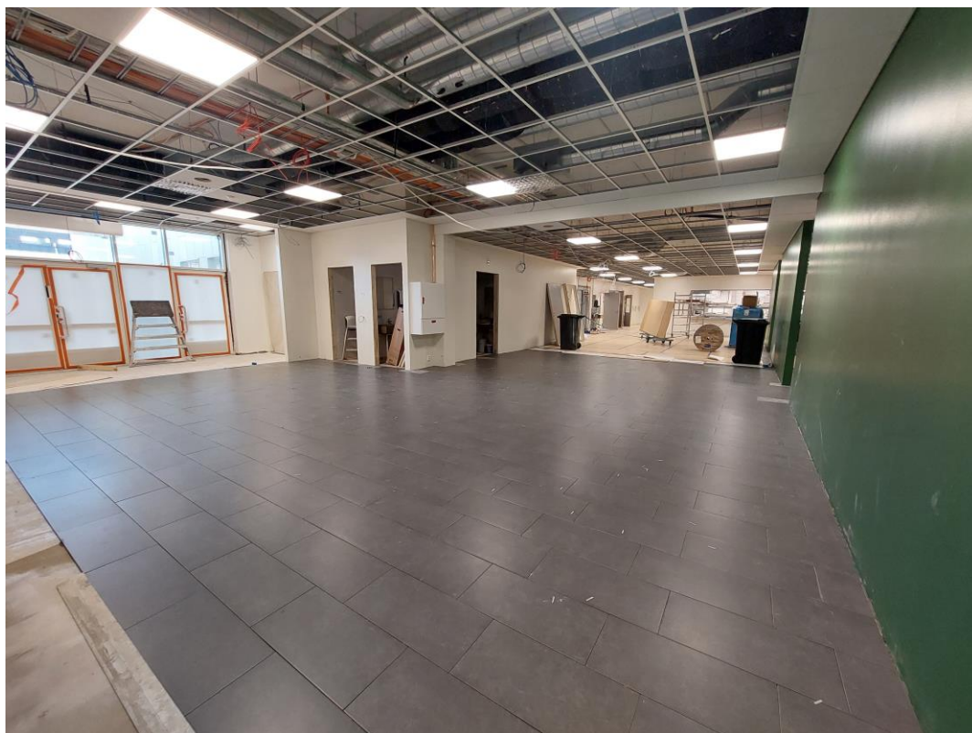
Kuva 7. 1.krs B-lohkolla pääsisäänkäyntiaulan lattialaatoitus käynnissä.
