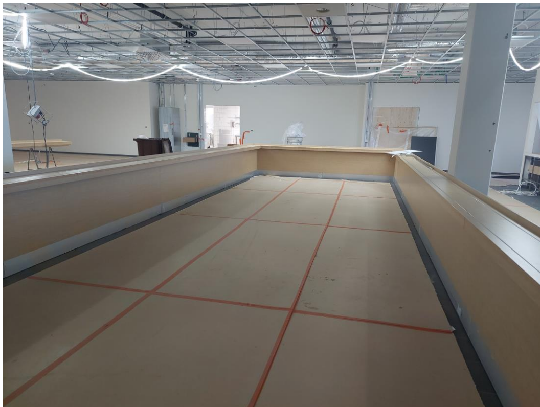
Kuva 6. 1.krs B-lohkolla asennettu tarjoilulinjastot, josta noudetaan keittiössä valmistettu ruoka.
