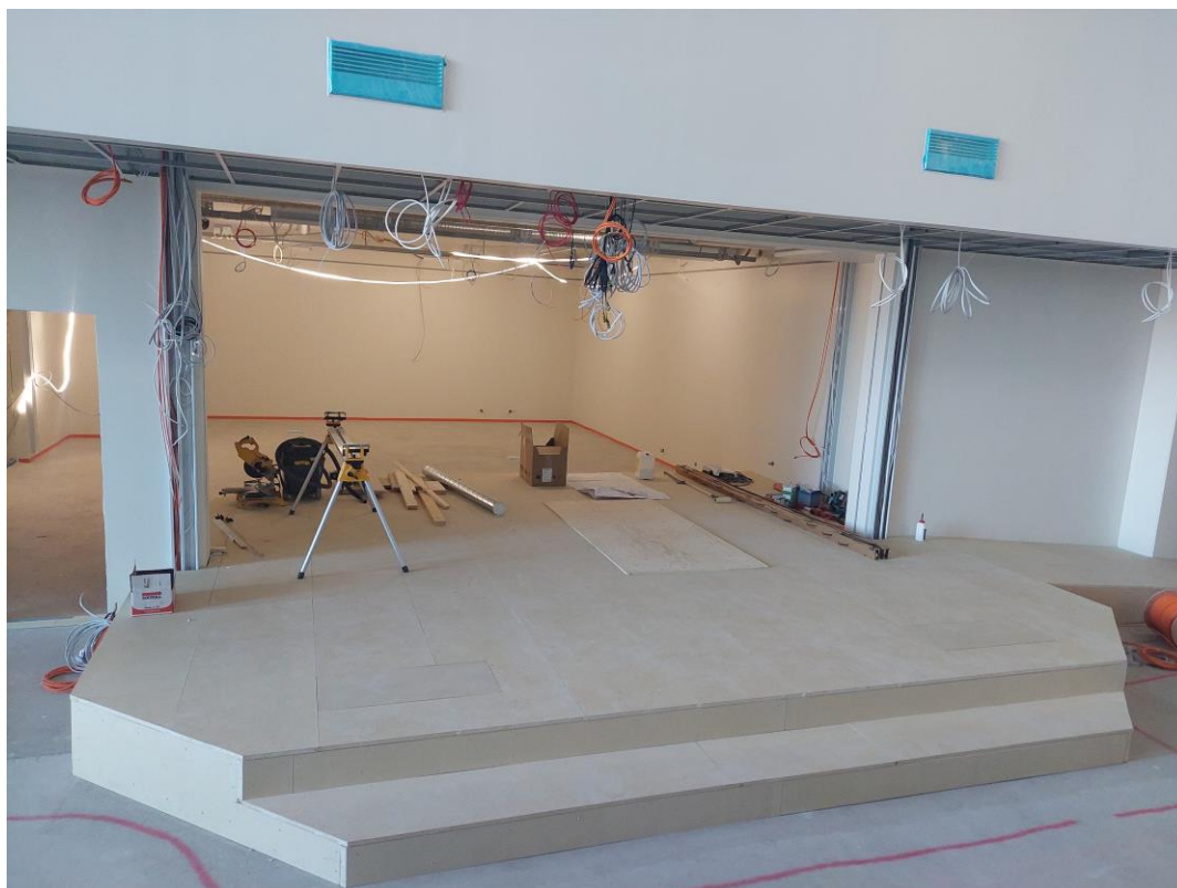
Kuva 8. 1.krs B-lohkolla lavan runko valmistunut. Esiintymisiä voidaan seurata ”jättiläisen portailta”.
