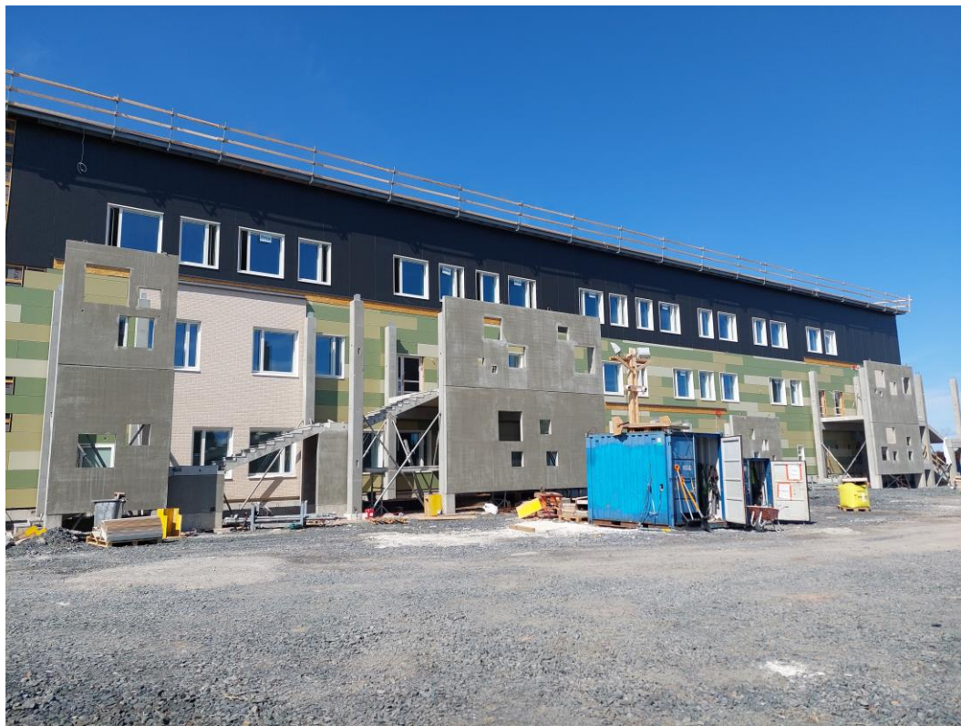
Kuva 2. Julkisivua itään. Ulkoportaikkojen elementit asennettu ja seuraavaksi tehdään sisäänkäynneille katokset.
