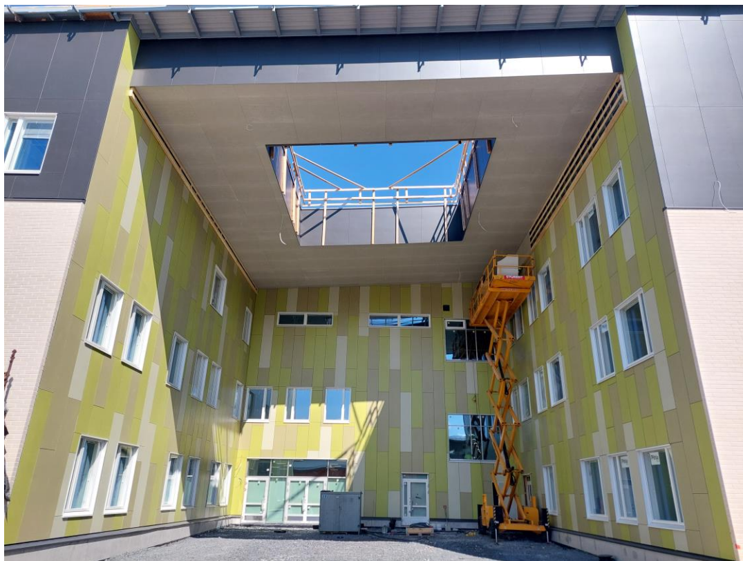
Kuva 3. Pääsisäänkäynnin alapuolen levytys lähes valmis. Kesäkuussa aloitetaan pihatyöt tällä alueella.
