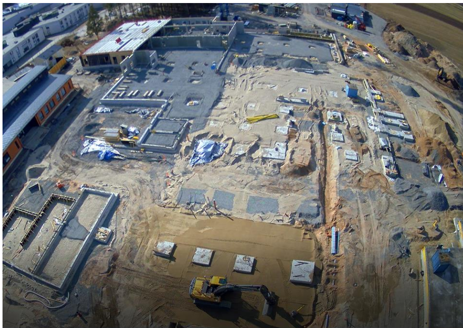
Kuva 2. Työmaatilanne 26.4.2022. Kuva otettu torninosturista ja kuvan yläreunassa näkyy A-lohkon 1.krs runkoa.
