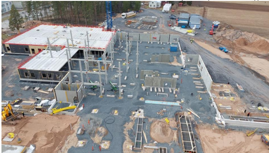
Kuva 3. Työmaatilanne 12.5.2022. Kuva otettu torninosturista ja runkotyöt käynnissä myös B-lohkolla.
