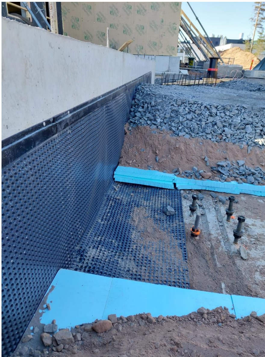
Kuva 7. Patolevyn ja routaeristyksen asennuksia A ja B loholla.
