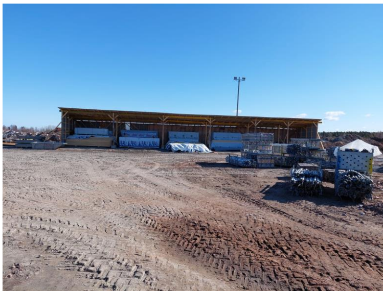
Kuva 10. Työmaalla rakennettu katos rakennusmateriaalin säilytystä varten.
