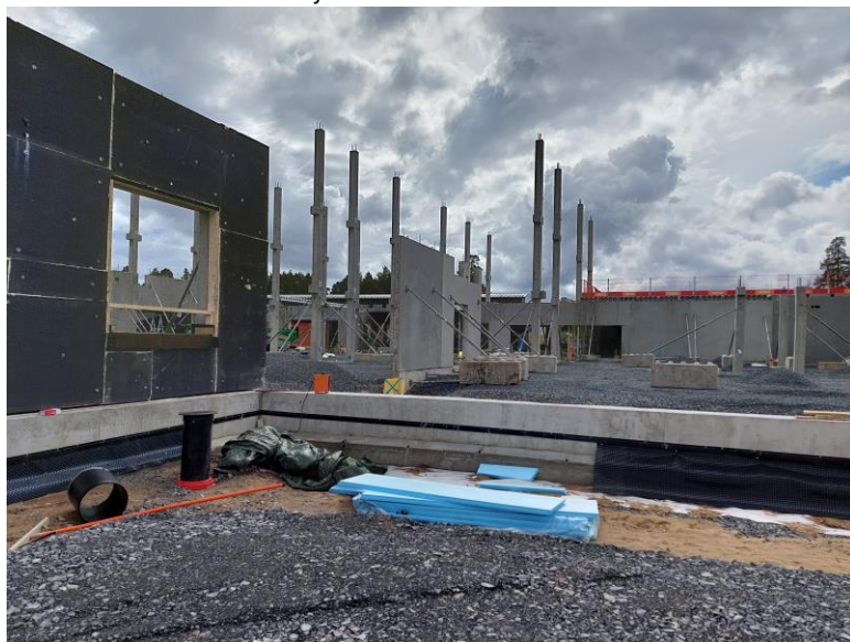
Kuva 5. Sisäkuori-, väliseinä- ja pilarielementtejä lohkolla B.
