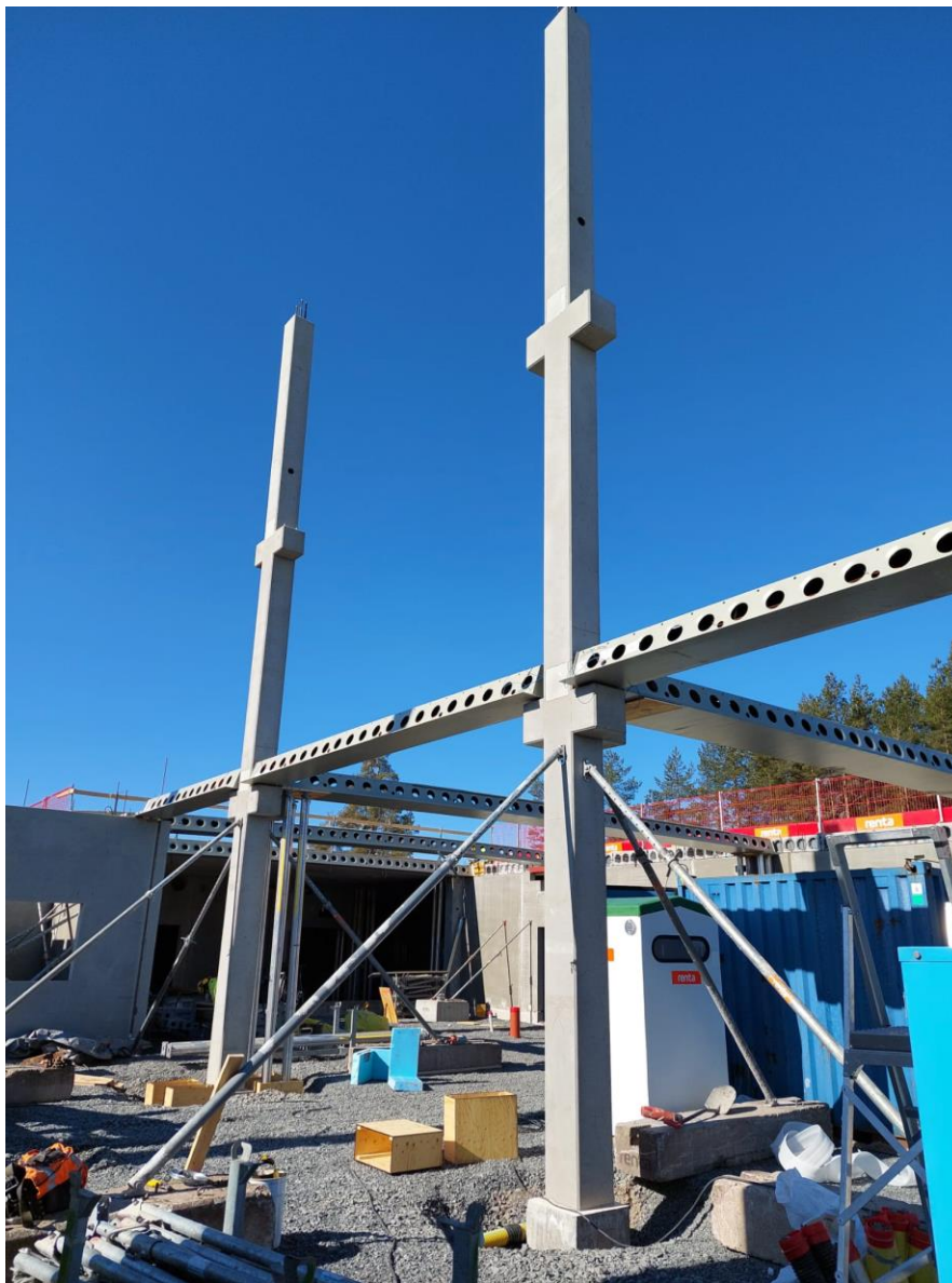
Kuva 9. Pilarielementit tuettu asianmukaisesti ja deltapalkit nostettu paikoilleen.
