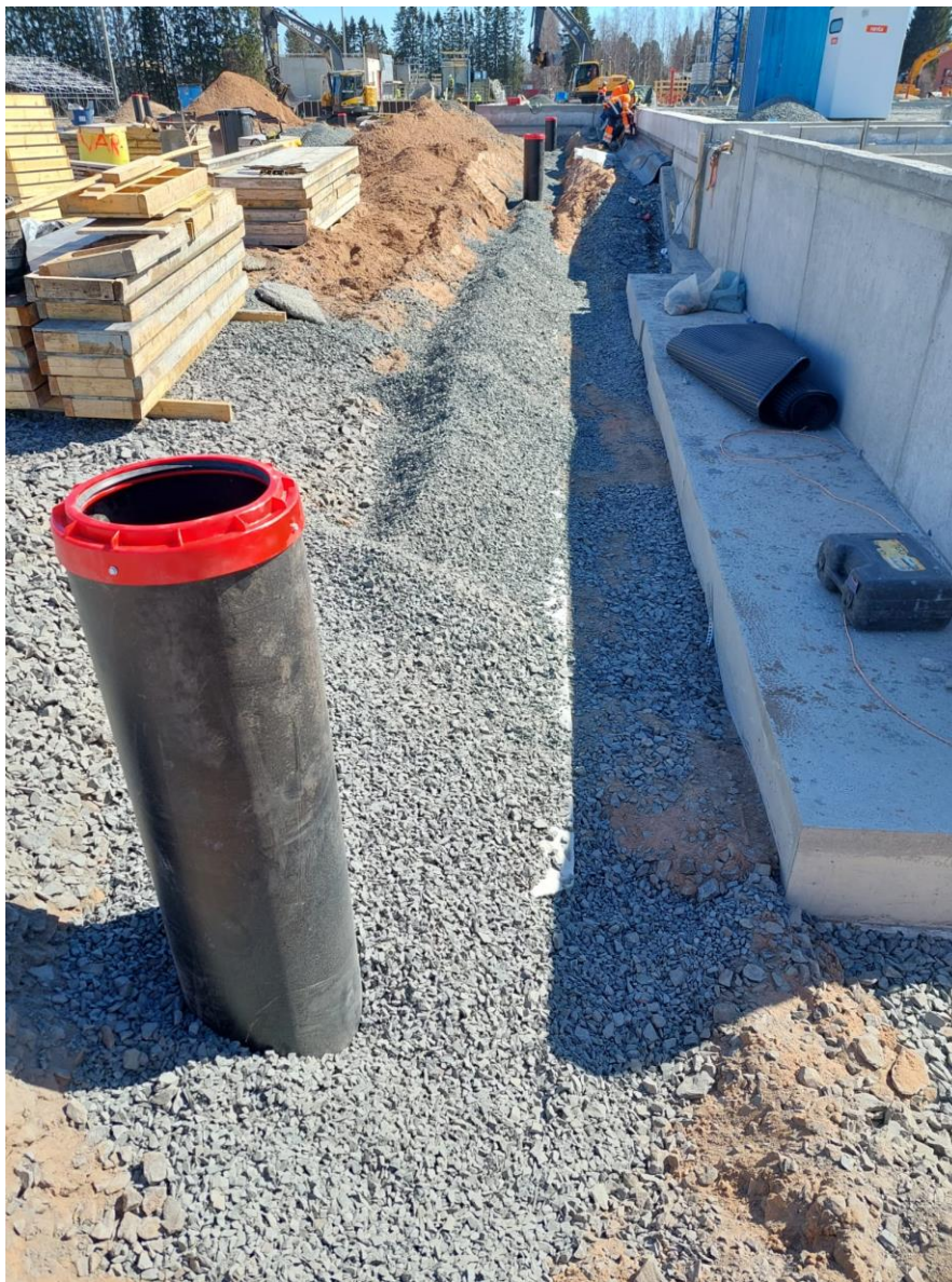
Kuva 8. Salaojaputkien ja kaivojen asennuksia A ja B lohkolla.
