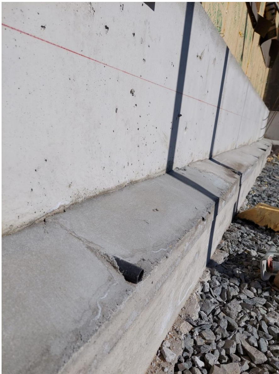
Kuva 6. Anturan päälle tehty kallistusvalu ja vedenpoistoputket asennettu.
