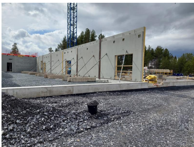
Kuva 4. Ulkoseinäelementtejä asennettu lohkolla A.
