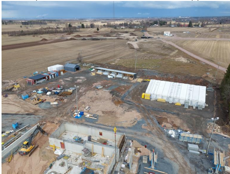
Kuva 11. Työmaan varastointialue jonne rakennusmateriaalit varastoidaan.
