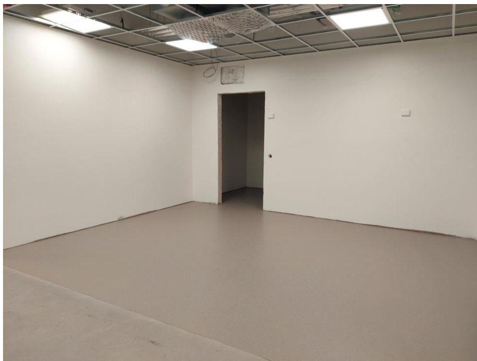
Kuva 5. 1.krs A-lohkolla aloitettu lattiapinnoitetyöt.
