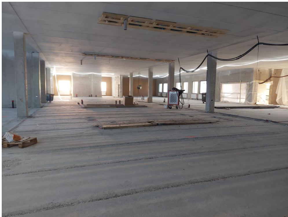
Kuva 8. 3.krs C-lohkoa. Seuraavina työvaiheina lämpö- ja vesijohtotyöt sekä väliseinätyöt.
