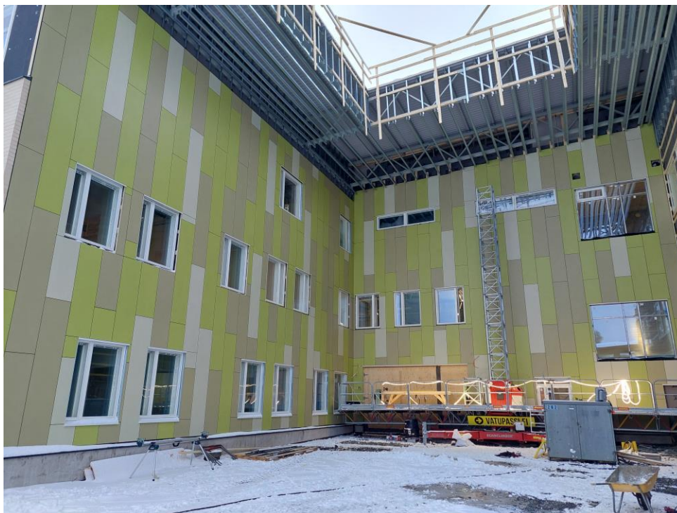
Kuva 3. Julkisivulevytystä pääsisäänkäynnin kohdalla.
