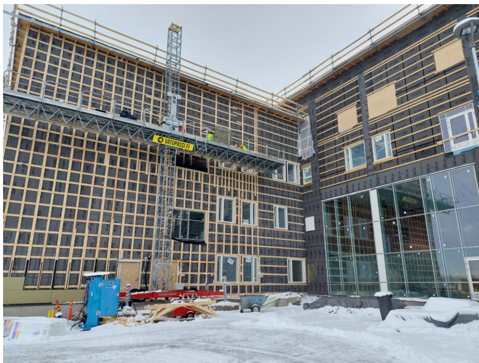
Kuva 4. Julkisivulevytyks aloitettu C-lohkolla.
