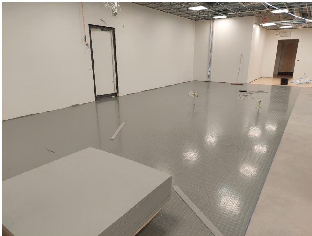
Kuva 7. Työn alla teknisen työn kumilaattalattia.
