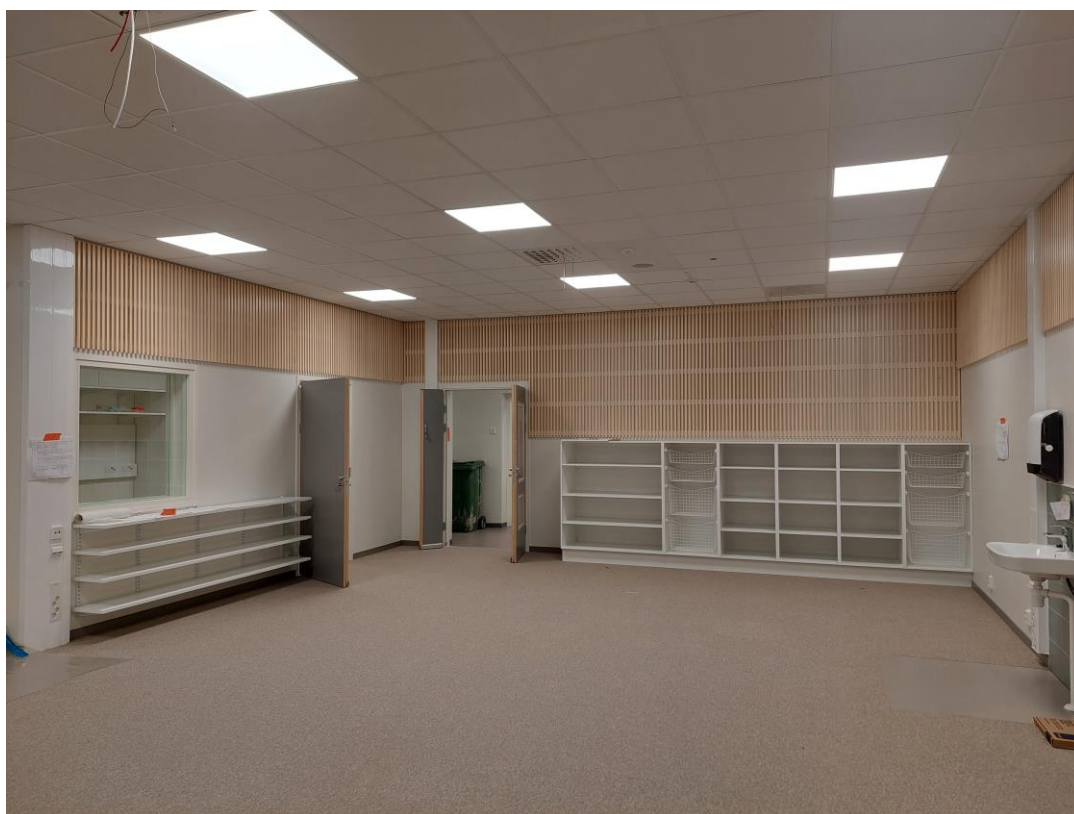
Kuva 6. Musiikkiluokkiin asennettu seinärimoitukset
