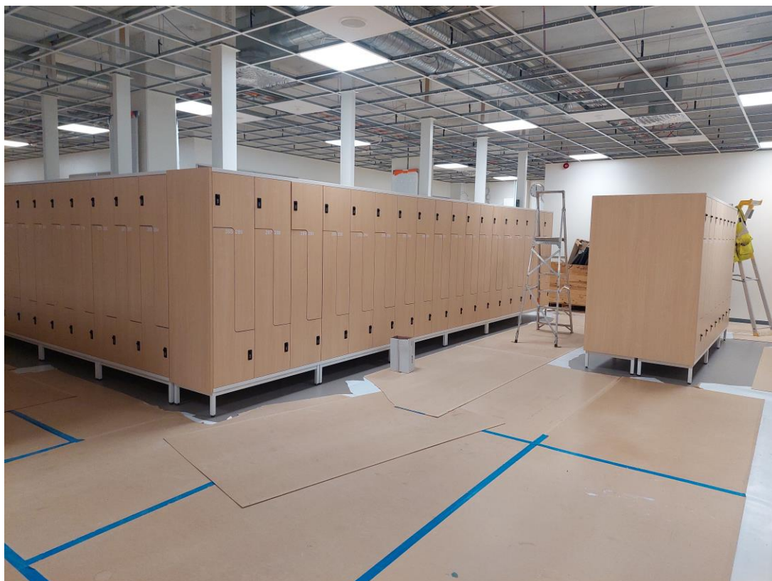
Kuva 9. 3.krs vaatekaapit asennettu
