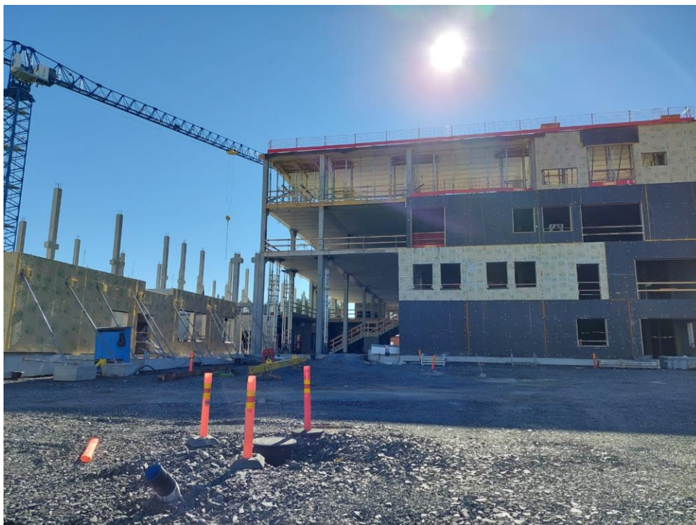
Kuva 7. Julkisivua pohjoiseen. Vasemmalla 1.krs C-lohkon ulkoseinäelementtejä asennettu.
