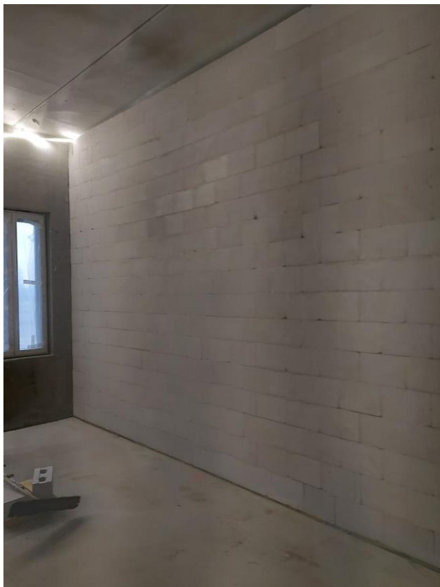
Kuva 8. Sisällä 1.krs A-lohkolla väliseinämuuraukset käynnissä.
