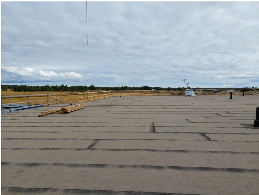
Kuva 6. A-lohkon vesikatonle on asennettu pohjahuovat.
