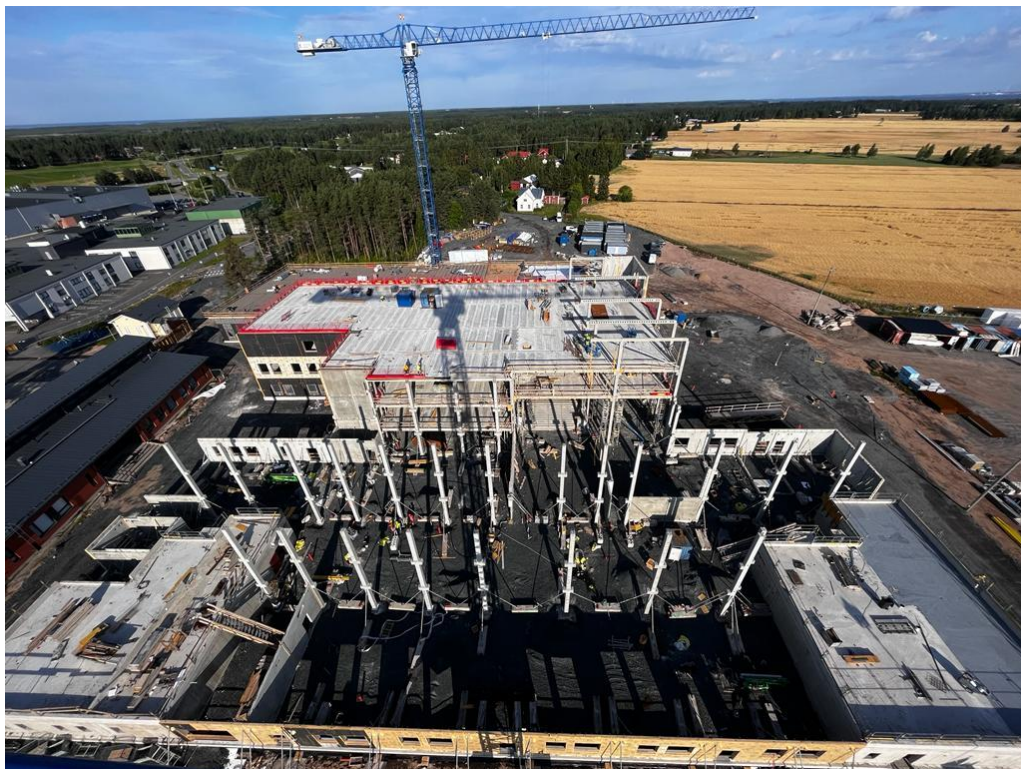
Kuva 2. Työmaatilanne 15.8.2022. Kuvan edustalla C-lohkon 1.krs runkotyöt käynnissä.
