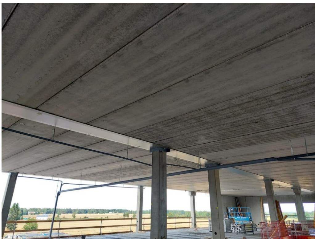
Kuva 5. Kuvassa 3.krs B-lohko. Kuvassa näkyvät väliaikaiset viemäriputket on liitetty katoilla oleviin kaivoihin. Sadevedet johdetaan näin hallitusti ulos rakennuksesta.
