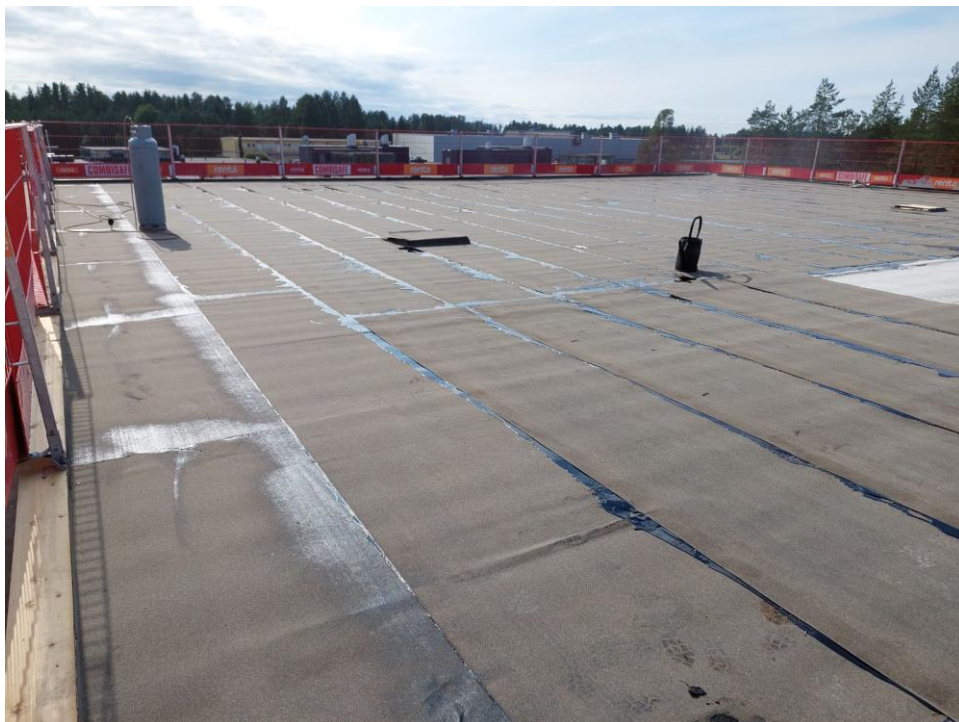
Kuva 4. Yläpohjan höyrynsulkuhuovan asennusta B-lohkolla 3.krs katolla. Huopa on liitetty työnaikaisiin kaivoihin, josta vesi johdetaan hallitusti alaspäin.
