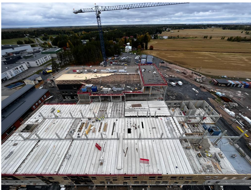
Kuva 3. Työmaatilanne 19.9.2022. Kuvan edustalla C-lohkon runkotyöt 2. kerroksessa. B-loholla vesikattotyöt edistyneet hyvin ja 4.krs IVKH katolle asennettu höyrynsulkuhuopa.
