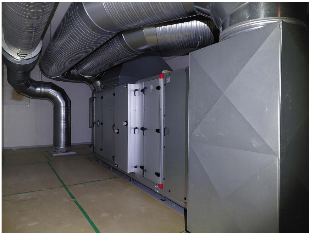
Kuva 8. 2.krs ilmanvaihtokonehuoneen asennuksia.
