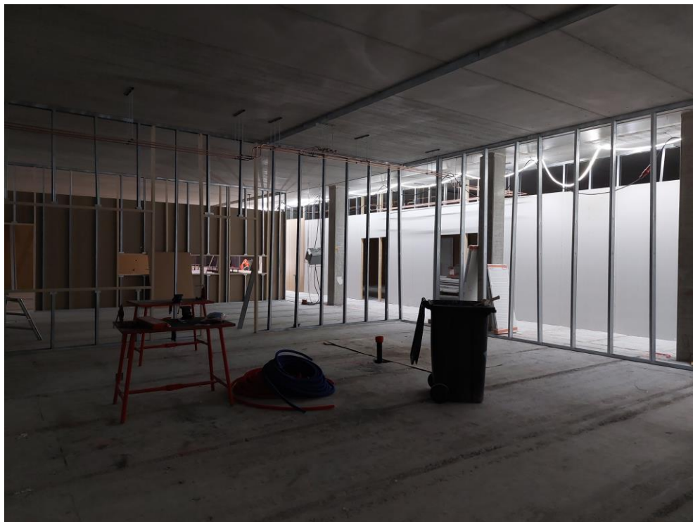
Kuva 10. 3.krs B-lohkolla väliseinätyöt käynnissä.
