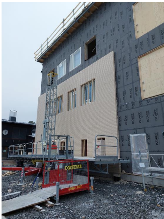
Kuva 6. C-lohkolla julkisivumuurausta.
