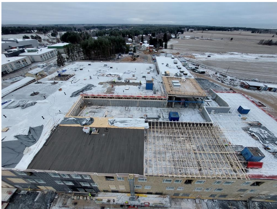
Kuva 3. Työmaatilanne 21.11.2022. Betonirunko valmistunut ja vesikattotyöt edenneet.
