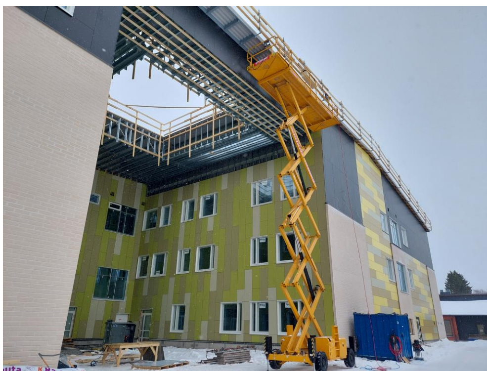
Kuva 3. Pääsisäänkäynnin kohdalla aloitettu katon alapuolen levytystyö.
