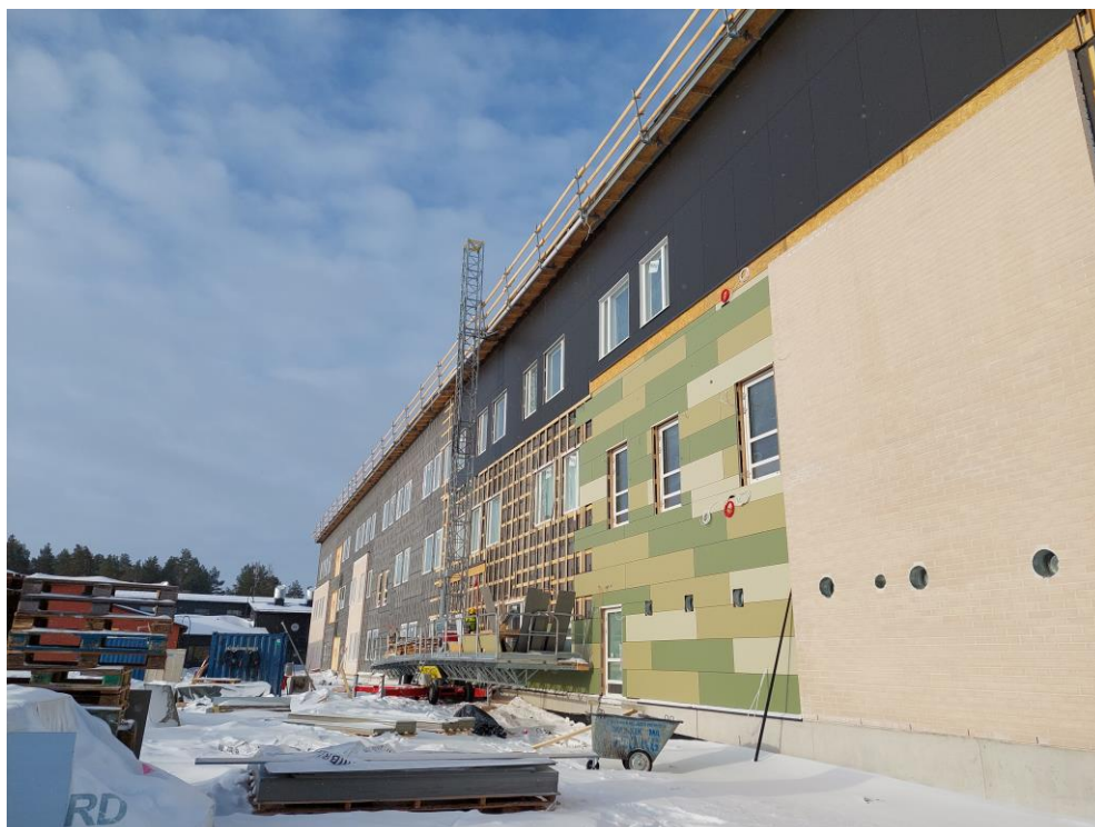
Kuva 2. Julkisivulevytystä C-lohkolla rakennuksen itäpuolella.
