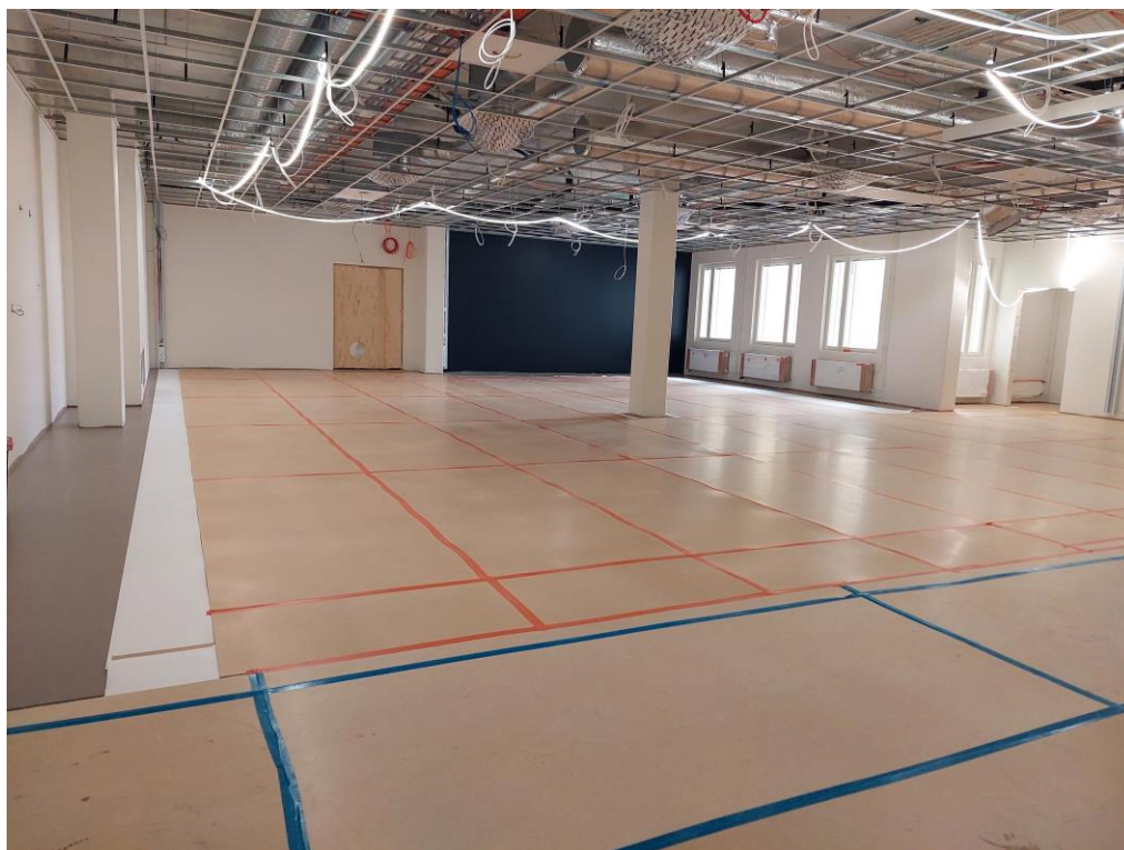
Kuva 6. 2.krs B-lohkolla lattiapinnoitukset pääosin valmiita.
