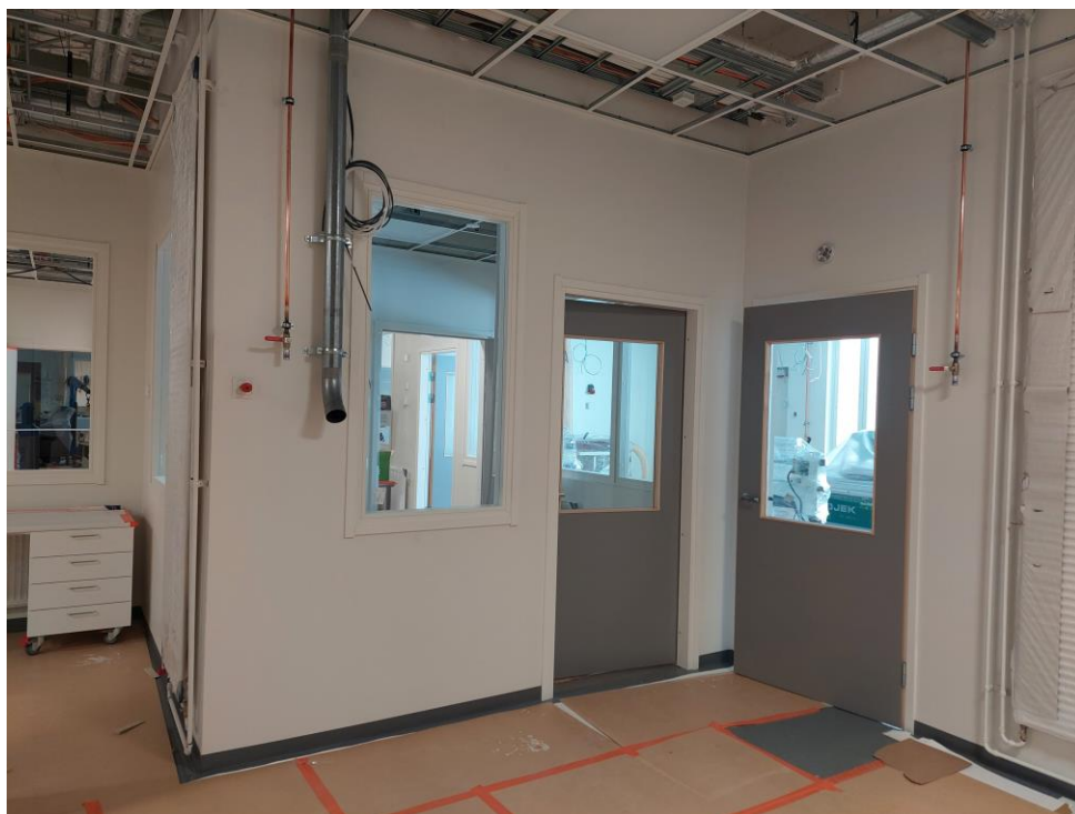
Kuva 11. 1.krs A-loholla oviasennukset ja listoitukset käynnissä.
