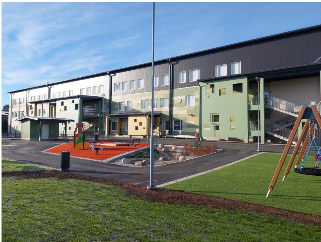
Kuva 1. Julkisivua itään. Pihan aidat pääosin asennettu ja ulkokaiteiden asennus kuvassa aloitettu
