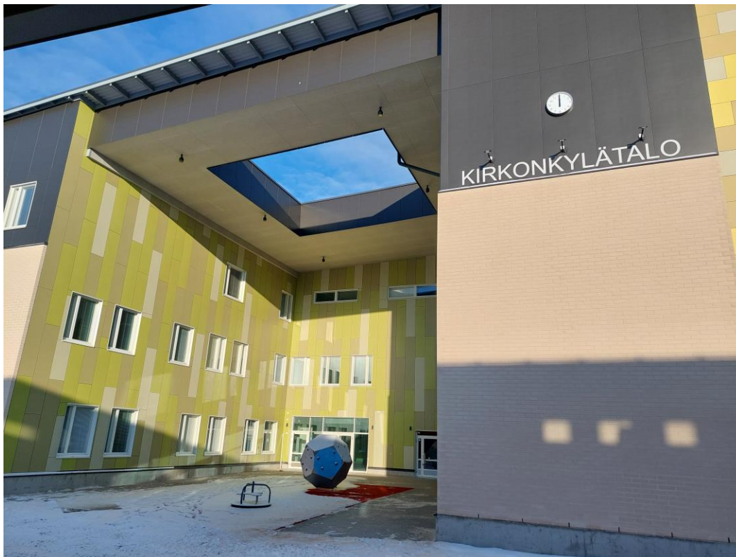
Kuva 2. Julkisivua etelään. Pääsisääkäynnin viereen asennettu nimikyltti
