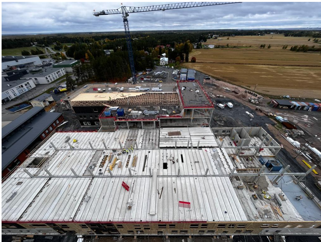
Kuva 2. Työmaatilanne 19.9.2022. Kuvan edustalla C-lohkon runkotyöt 2. kerroksessa. B-lohkokolla vesikattotyöt edistyneet hyvin ja 4.krs IVKH katolle asennettu höyrynsulkuhuopa.
