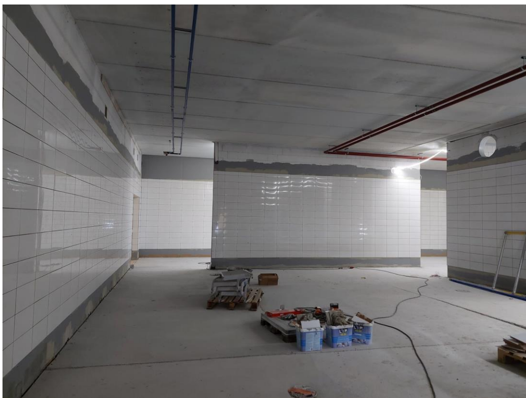
Kuva 7. Keittiön laatoitukset ovat edenneet pitkälle.
