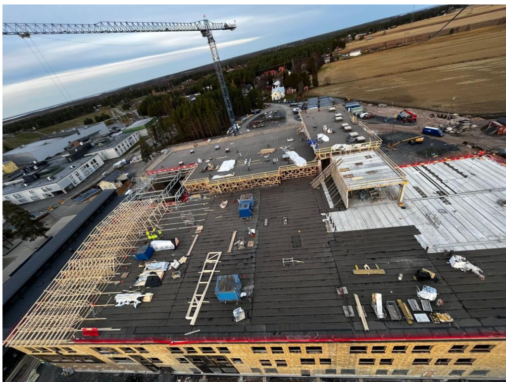
Kuva 3. Työmaatilanne 24.10.2022. Kuvan edustalla C-lohkon runkotyöt pääosin valmistuneet ja vesikattotyöt aloitettu. B-lohkokolla asennetaan teräsrakenne kattoa ja 4.krs IVKH katolle asennettu valmistuneelle osalle pohjahuopa.
