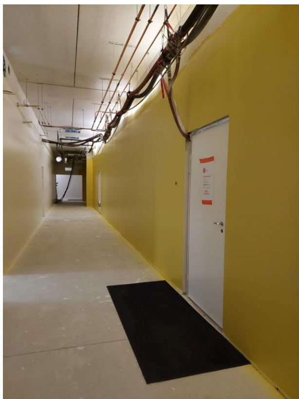
Kuva 9. Maalaustyöt valmistuneet pääosin 1.krs A-lohkolla. Kuvassa oven takana on ensimmäinen P1-puhtausluokan osasto. Pölyävät työvaiheet on tehty ja IV- ja sähkötyöt aloitettu.
