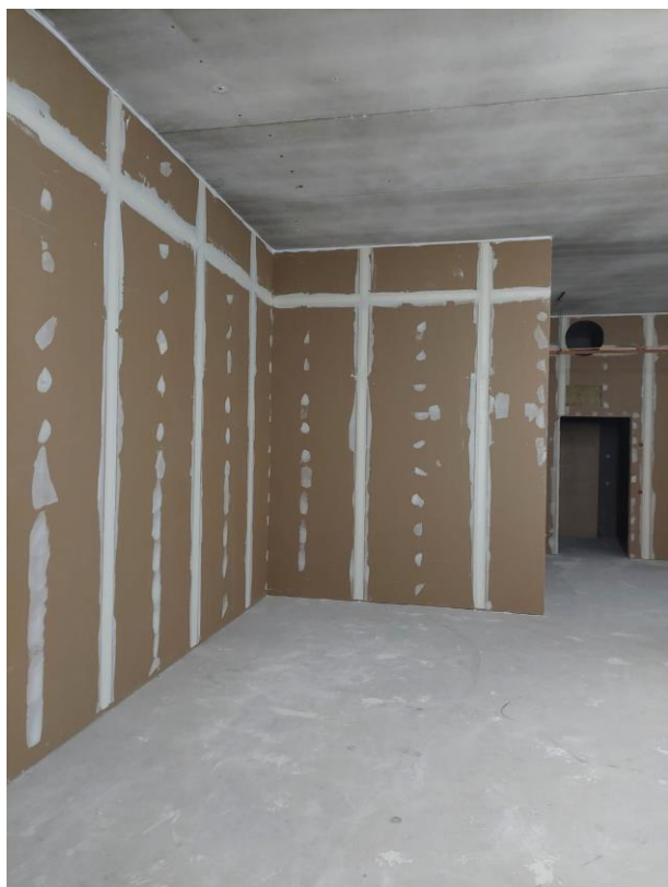
Kuva 8. Väliseinätyöt on aloitettu 2.krs B-lohkolla ja tasoitetyöt on käynnissä 1.krs B-lohkolla.
