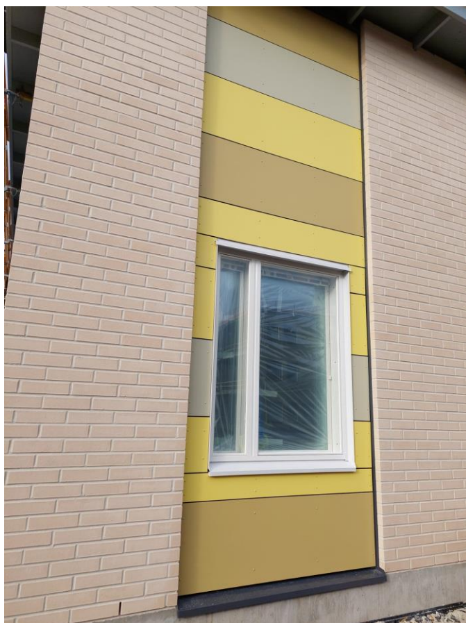
Kuva 5. Julkisivulevytyksen mallikatselmus pidettiin 14.10.2022 ja viikolla 42 päästiin aloittamaan julkisivulevytys A-lohkolla.
