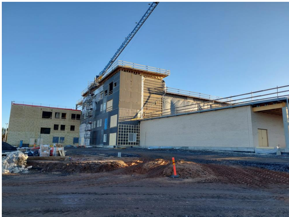
Kuva 4. A-lohkolla julkisivumuuraus on pääosin valmistunut ja muurarit ovat siirtyneet B-lohkolle.
