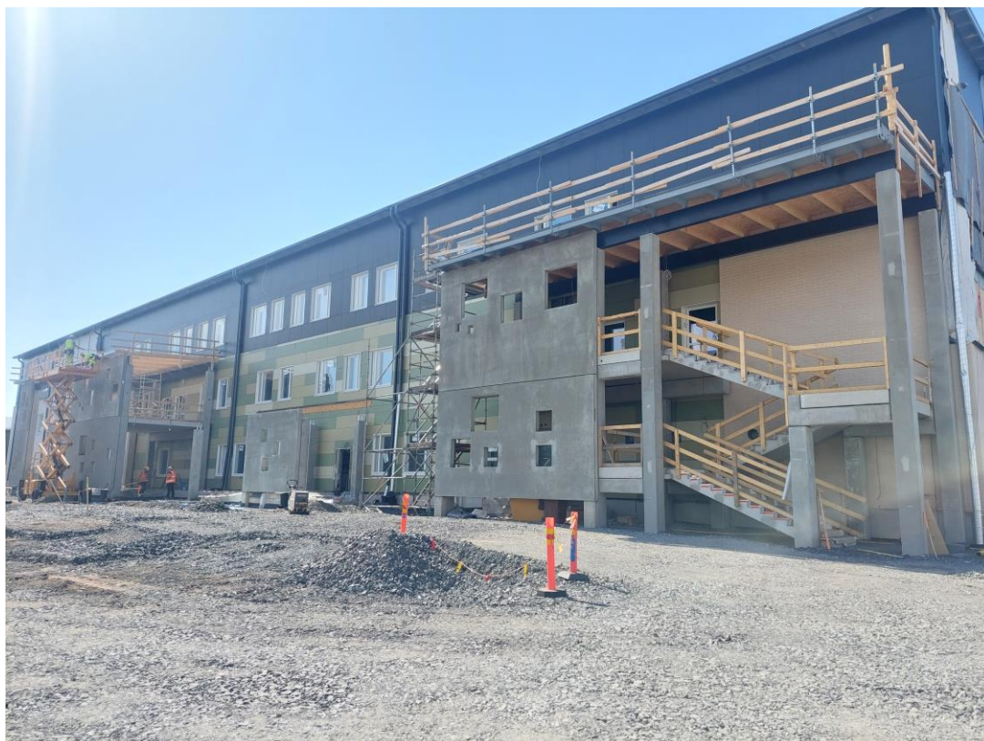
Kuva 2. Julkisivua itään. Rännikourut ja syöksytorvet asennettu. Ulkoportaikkojen katokset työn alla sekä asfaltti ja kivipohjien profilointi.
