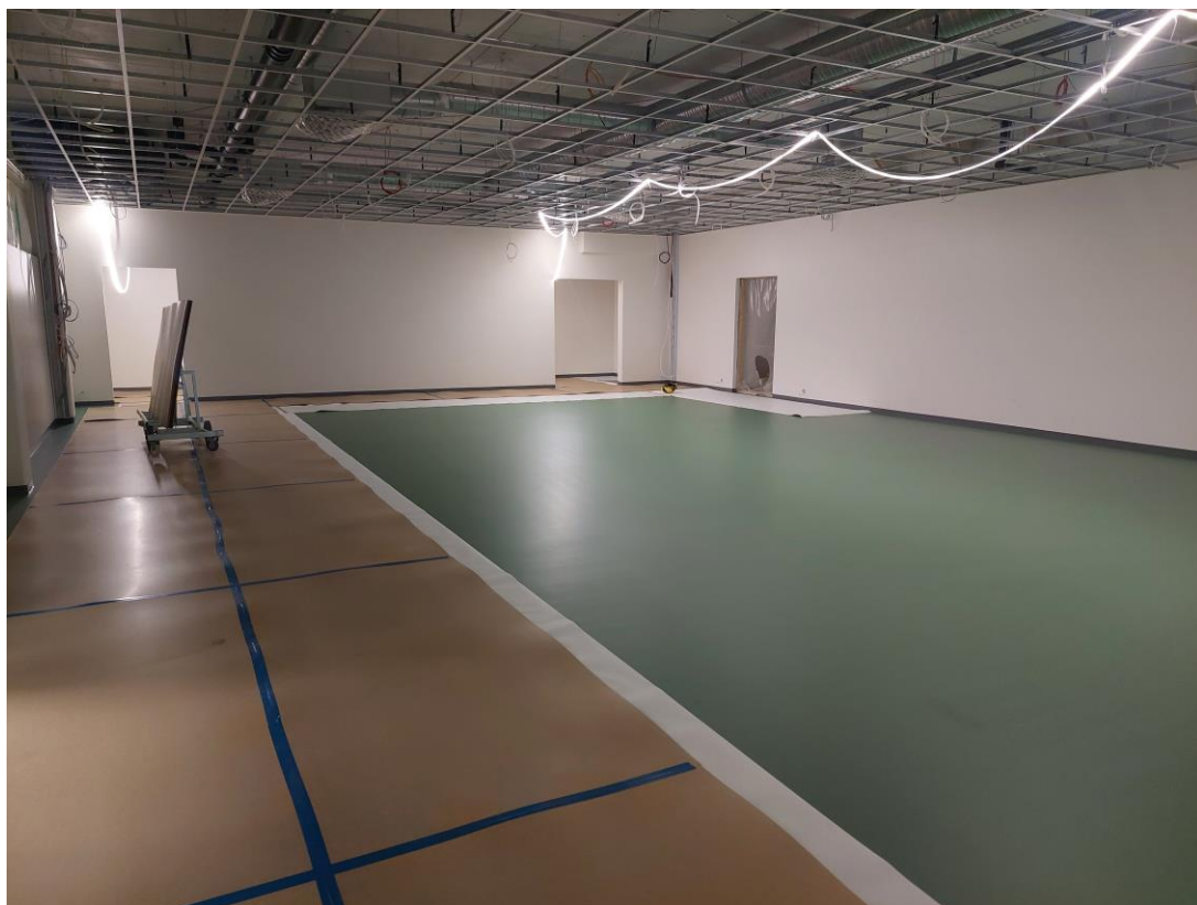
Kuva 10. 1.krs C-lohkolla monitoimisalın lattia pinnoitettu.
