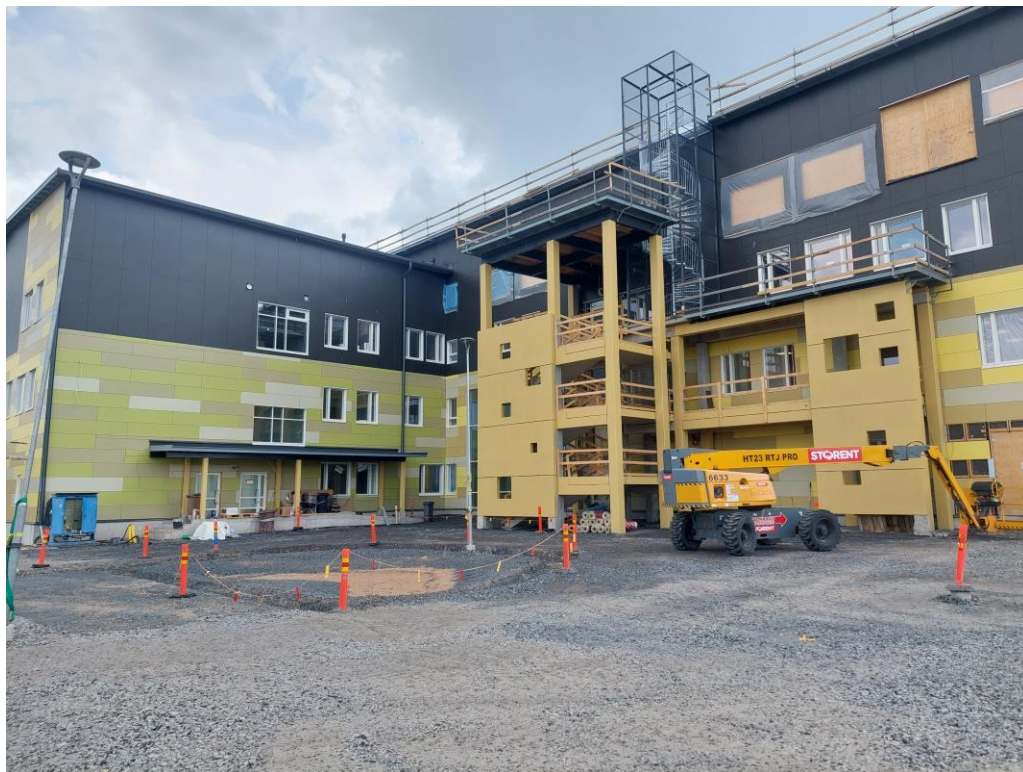
Kuva 4. Rakennuksen pohjoispuolella ulkoportaikkoa maalattu.
