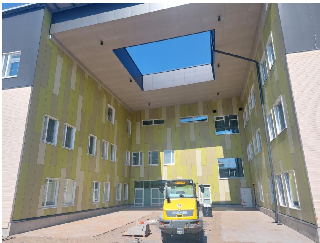
Kuva 3. Pääsisäänkäynnin pihakivien asennus pääosin valmis.
