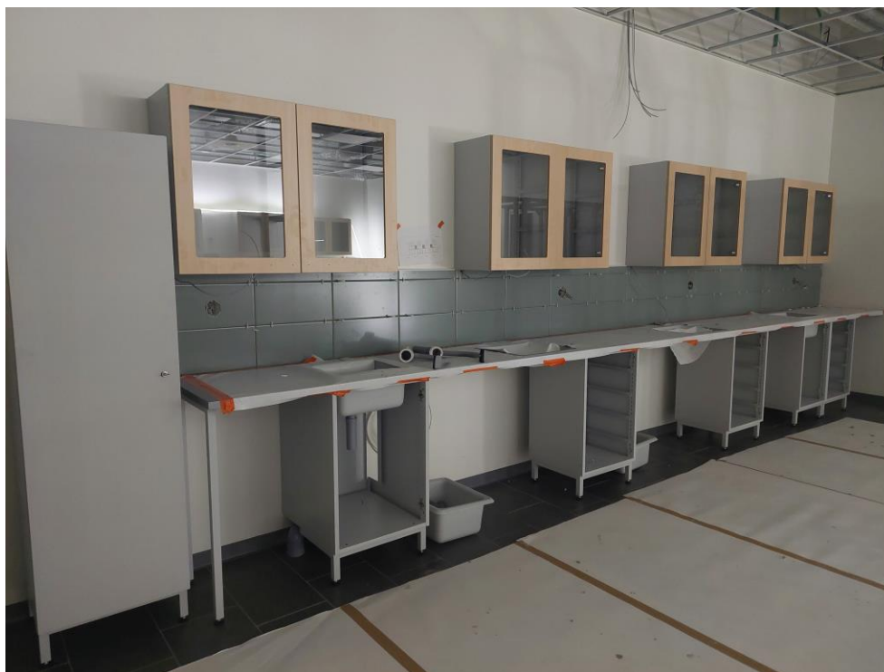
Kuva 9. 3.krs B-lohkolla FYKE luokkien kalusteasennuksia ja välitilalaatoitukset työn alla.
