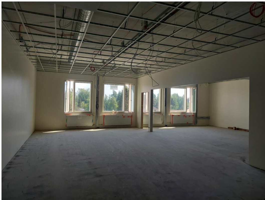
Kuva 12. 3.krs C-lohkolla alakattorungot käynnissä.
