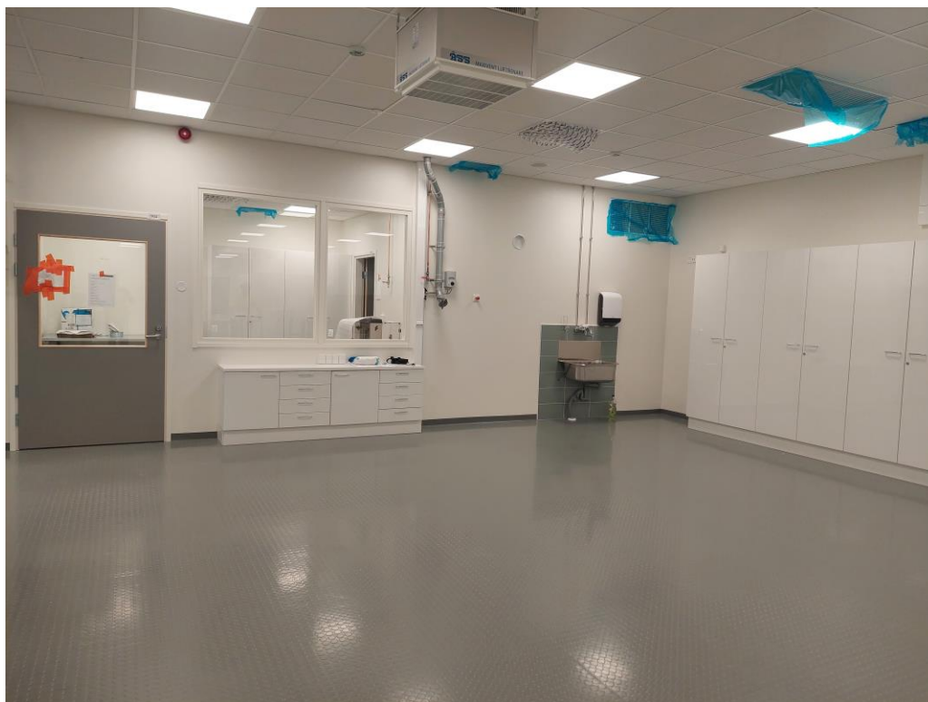
Kuva 5. 1.krs A-lohkolla teknisen työn tilan alakaton yläpuolet siivottu, tarkastettu ja alakatot levytetty.
