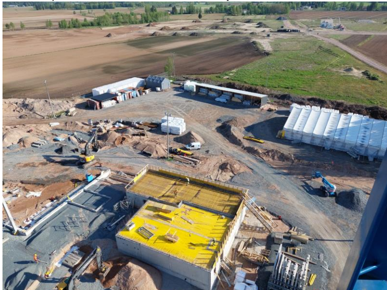
Kuva 5. Väestönsuoja 3 ja 4 holvin raudoitustyöt käynnissä.
