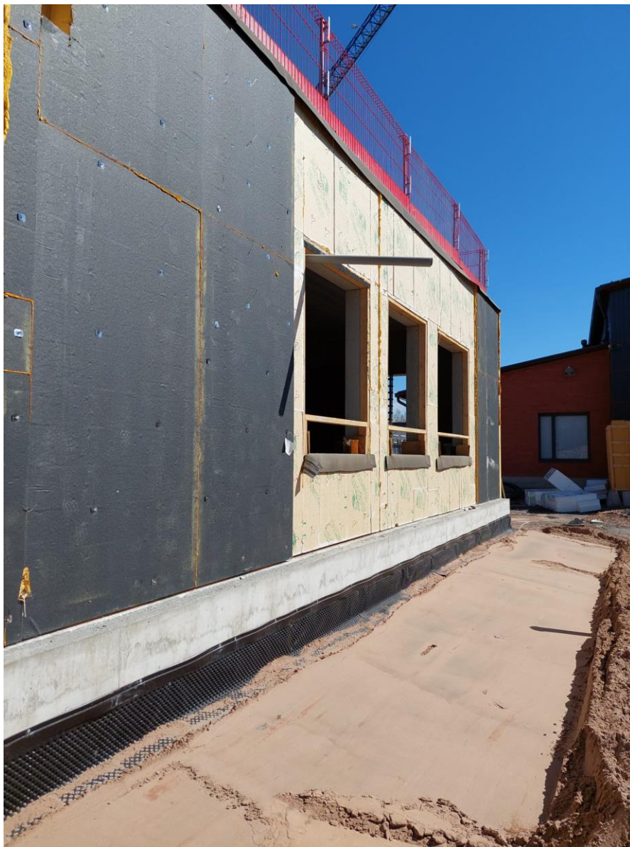
Kuva 7. Patolevyn ja routaeristyksen asennuksia A ja B lohkoilla.
