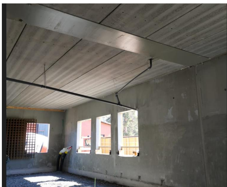
Kuva 10. Yläpohjaan on tehty työnaikaiset kaivot, josta vedet ohjataan viemäriputkilla hallitusti ulkopuolelle viemäriin.
