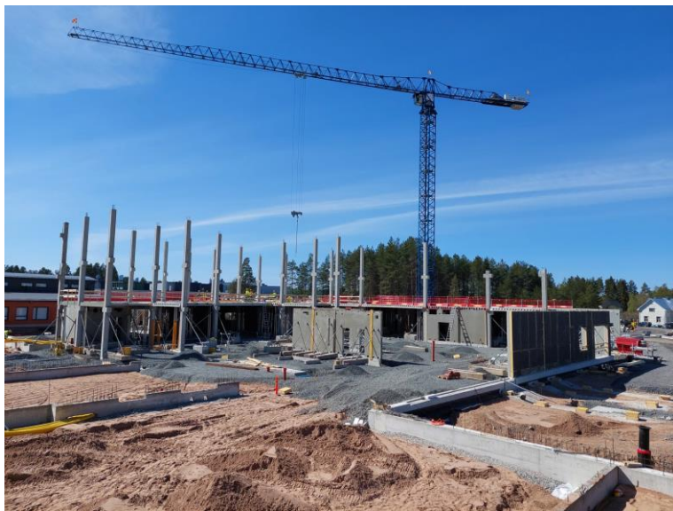
Kuva 2. Työmaatilanne 23.5.2022. Kuvassa A ja B-lohkon 1.krs runkoa.
