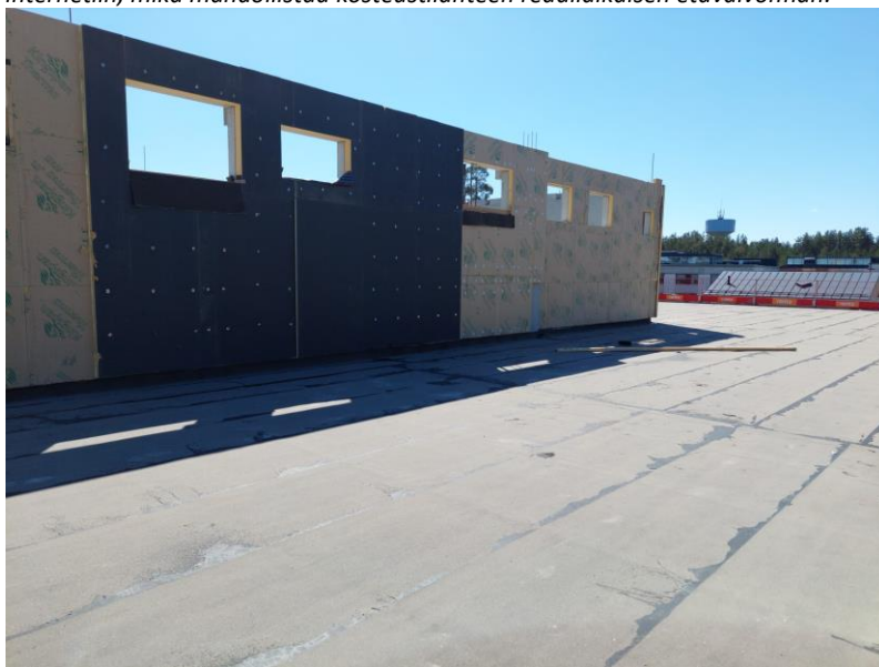
Kuva 9. 2.krs IVKH ulkoseinäelementit asennettu. A-lohkon 1.krs yläpohjan höyrynsulku asennettu.
