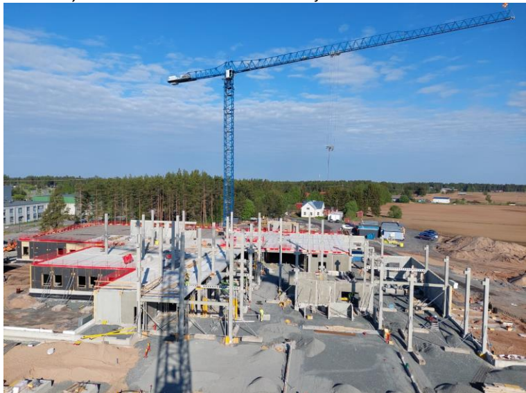
Kuva 3. Työmaatilanne 31.5.2022. Kuva otettu torninosturista ja runkotyöt käynnissä myös B-lohkolla. 2.krs elementtiasennukset aloitettu.
