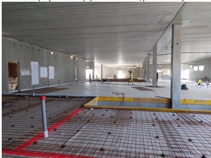
Kuva 11. Maanvaraiset lattiatyöt on aloitettu A-lohkolla.
