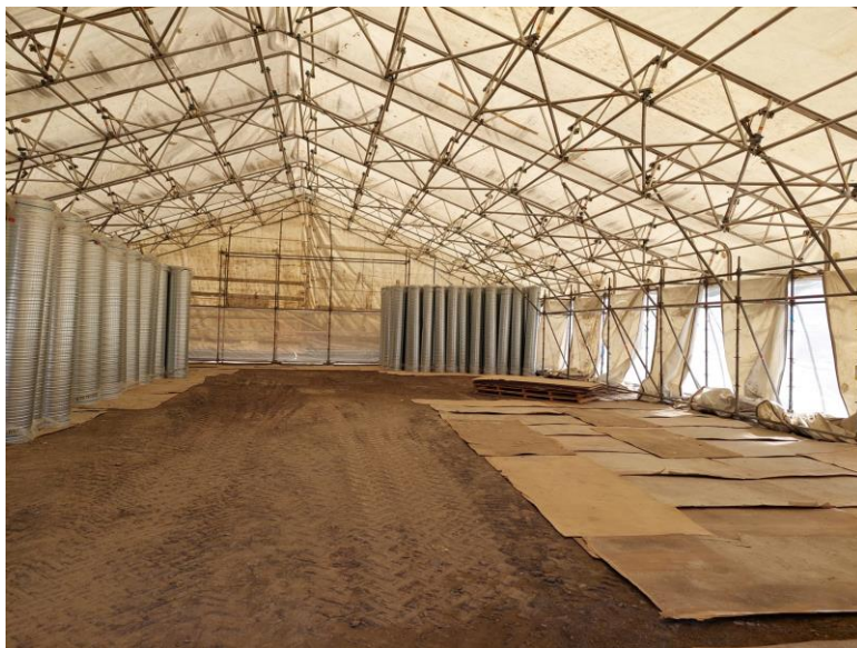
Kuva 4. Työmaalle on hankittu 500m 2 sääsuojateltta materiaalin varastointia varten.
