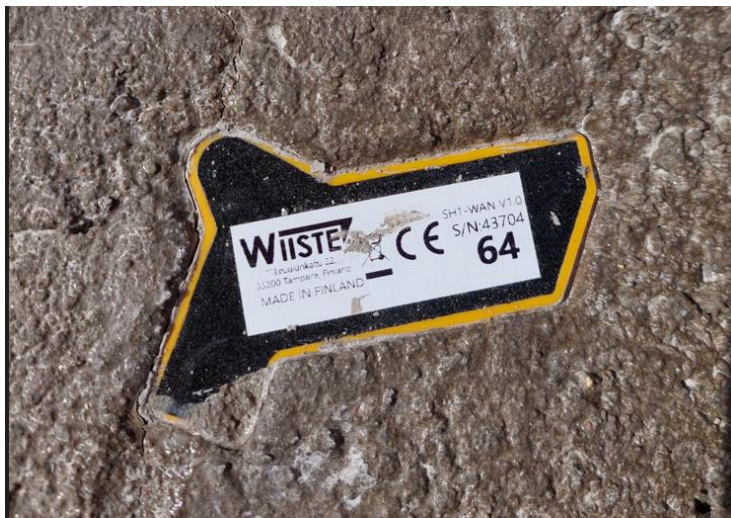
Kuva 8. Betonin kosteus- ja lämpötilaseuranta etäluettavilla Wiiste SH1-WAN antureilla. Anturi lähettää mittaustiedot internetiin, mikä mahdollistaa kosteustilanteen reaaliaikaisen etävalvonnan.
