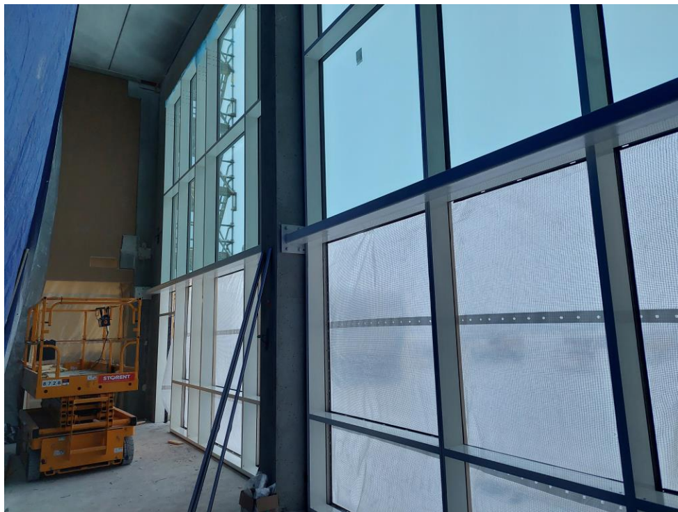
Kuva 8. Joulukuussa asennettiin alumiiniulko-ovia, alumiini-ikkunoita sekä lasiseinä. Kuvassa ruokalan lasiseinä.
