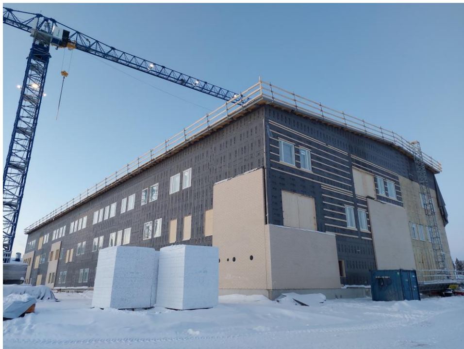
Kuva 2. Työmaatilanne 23.12.2022. Vesikatto on saatu C-lohkolla myös pääosin tehtyä. Julkisivun eristys on tehty, ikkunat pääosin asennettu ja julkisivumuuraus pääosin tehty.
