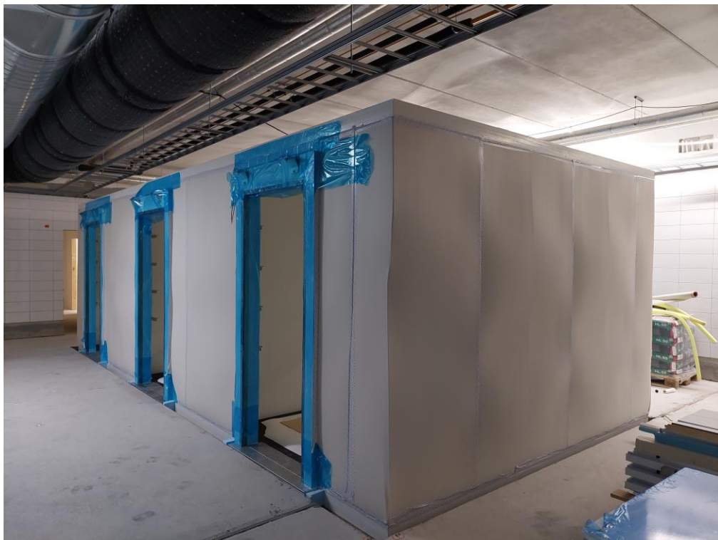
Kuva 6. Keittiön pakastehuoneet asennettu ja suojattu.
