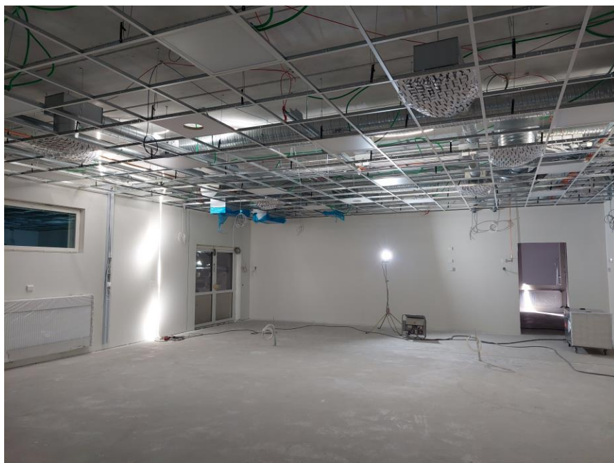
Kuva 4. Ensimmäisellä P1-alueella alakattorungot valmistuneet ja ilmanvaihdon päätelaitteet sekä valaisimet asennettu.
