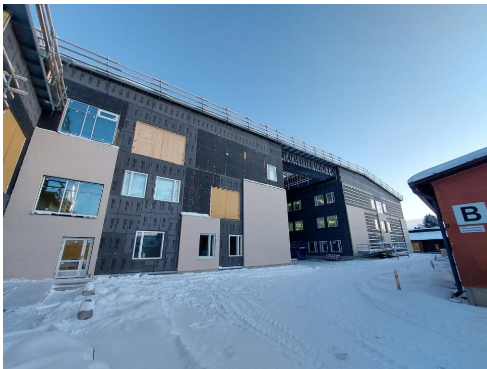
Kuva 3. Julkisivu etelään. Kuvassa julkisivun syvennyksessä on eteläpuolen sisäänkäynti. Syvennys on katettu teräsrakennuseristikoilla, jossa on valoaukko.
