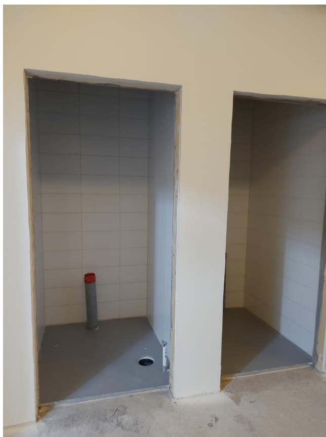
Kuva 5. 1.krs WC seinälaatoituksia ja ensiviikolla alkaa lattiaaatoitukset.
