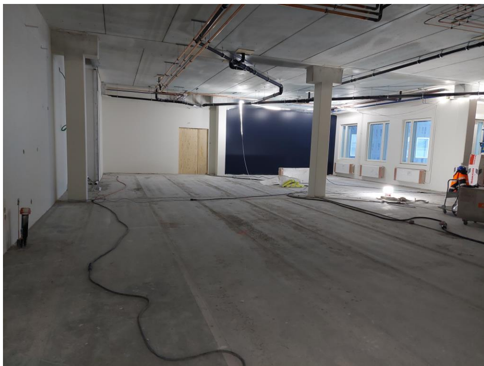
Kuva 10. 2.krs B-lohkon P1-osastoa. Ensivuoden alkupuolella aloitetaan iv- ja sähköasennukset tällä alueella.
