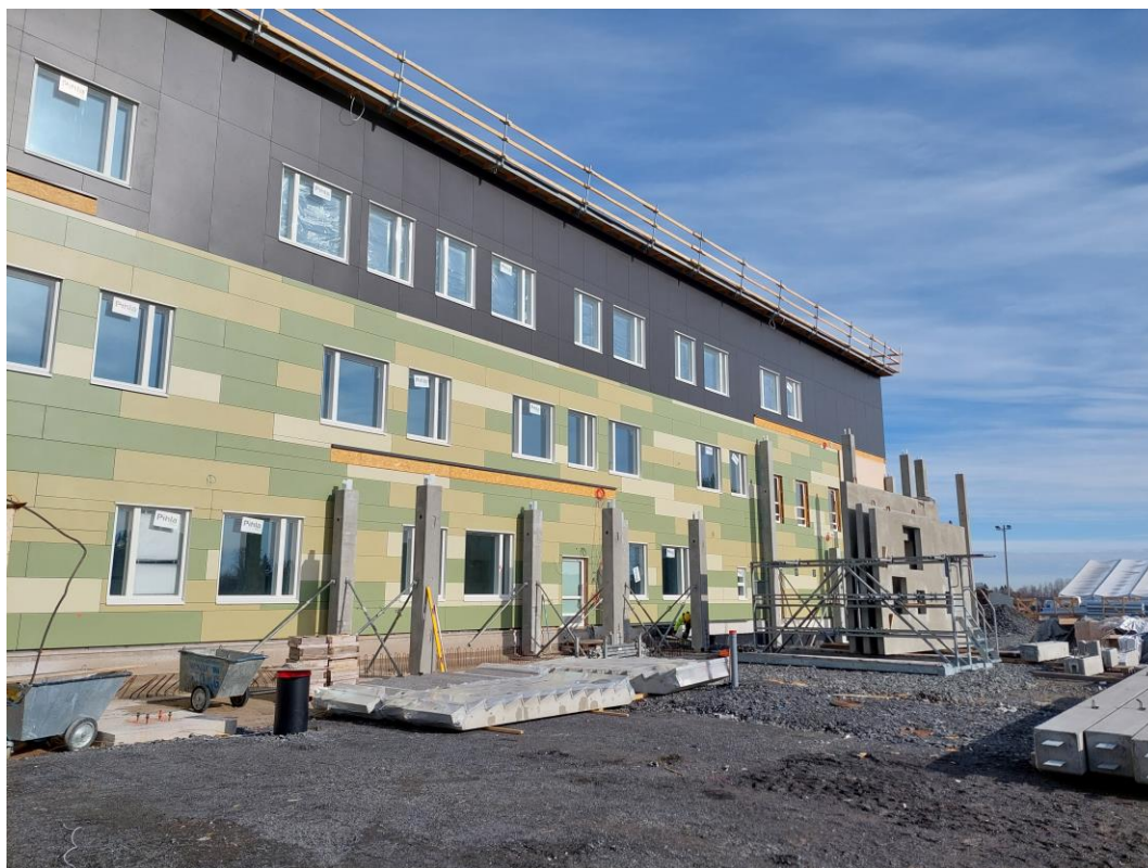
Kuva 2. Julkisivua itään. Julkisivulevytytys on nyt pääosin tehty ja ulkoportaikkojen asennus aloitettu.
