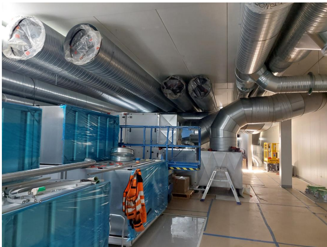
Kuva 10. 4.krs IVKH asennuksia.
