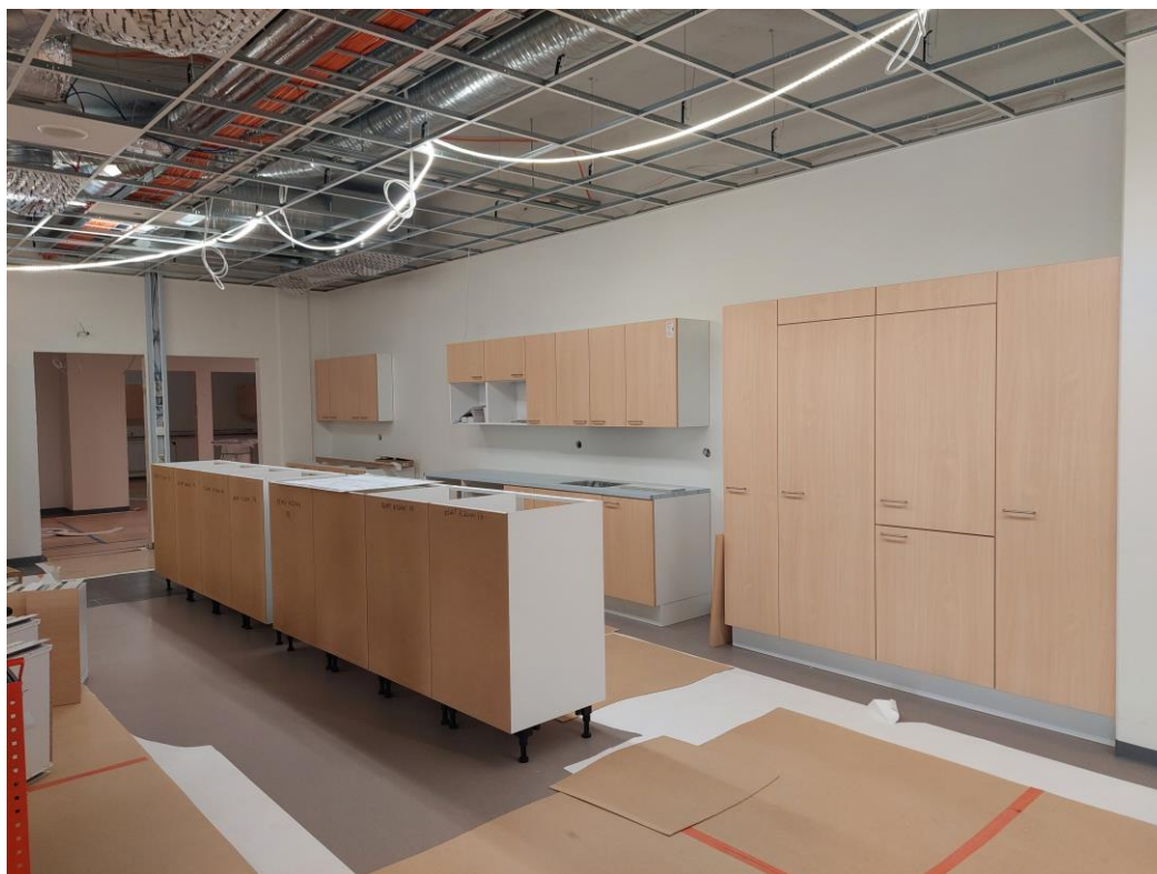
Kuva 8. 2.krs B-lohkon kalusteasennuksia.
