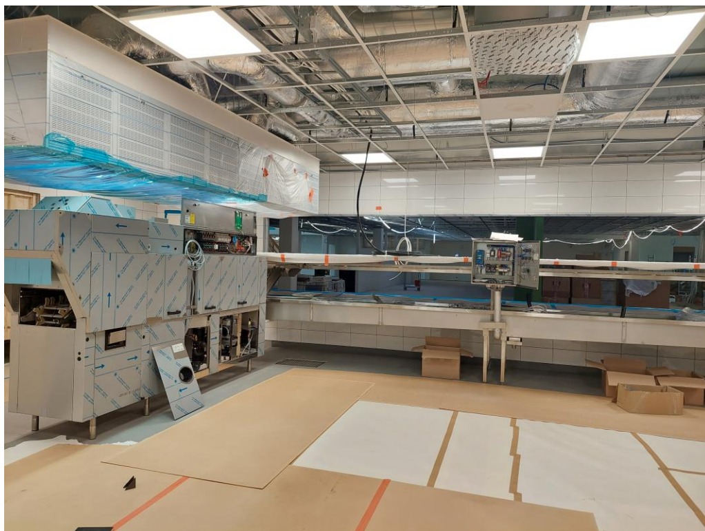
Kuva 4. Keittiölaiteasennukset aloitettu. Kuvassa astioiden palautuslinjastoa.
