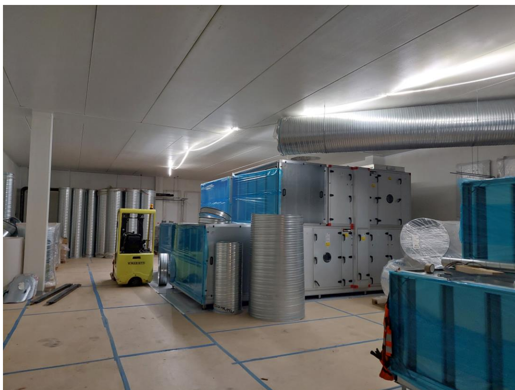
Kuva 9. 4.krs IVKH asennukset edistyneet. Kaikki ilmanvaihtokoneet ovat omilla paikoillaan.
