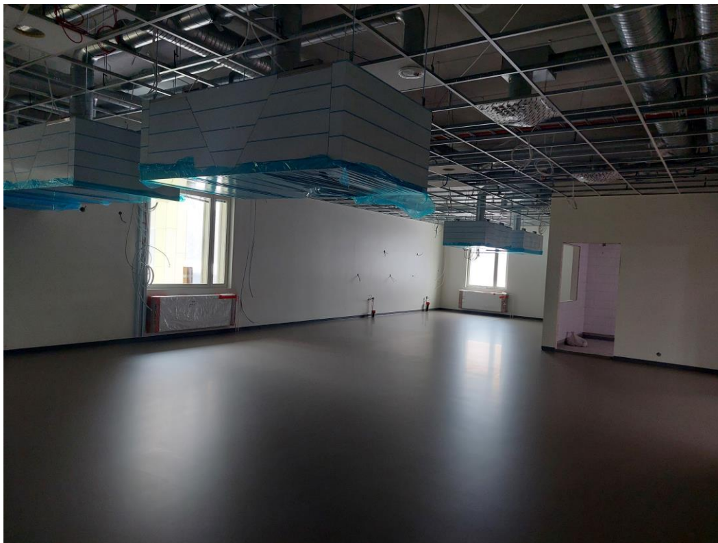
Kuva 6. 3.krs B-lohkolla kotitalousluokan lattiapinnoitus valmiina.
