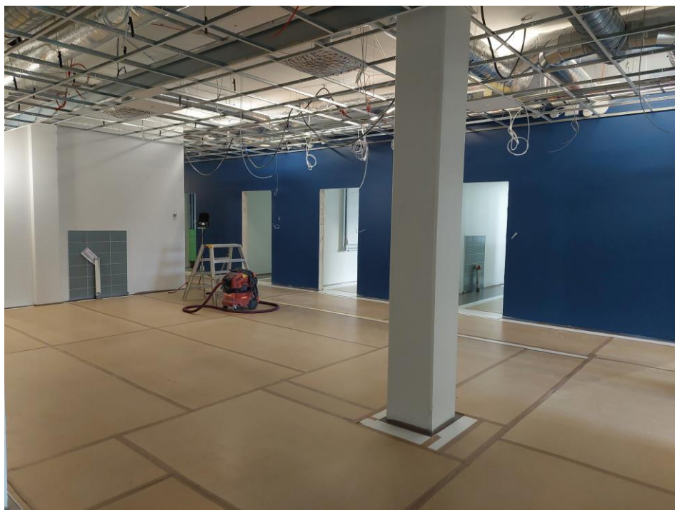
Kuva 5. 1.krs B-lohkolla lattiapinnoitukset osittain valmistuneet ja lattiat suojattu.
