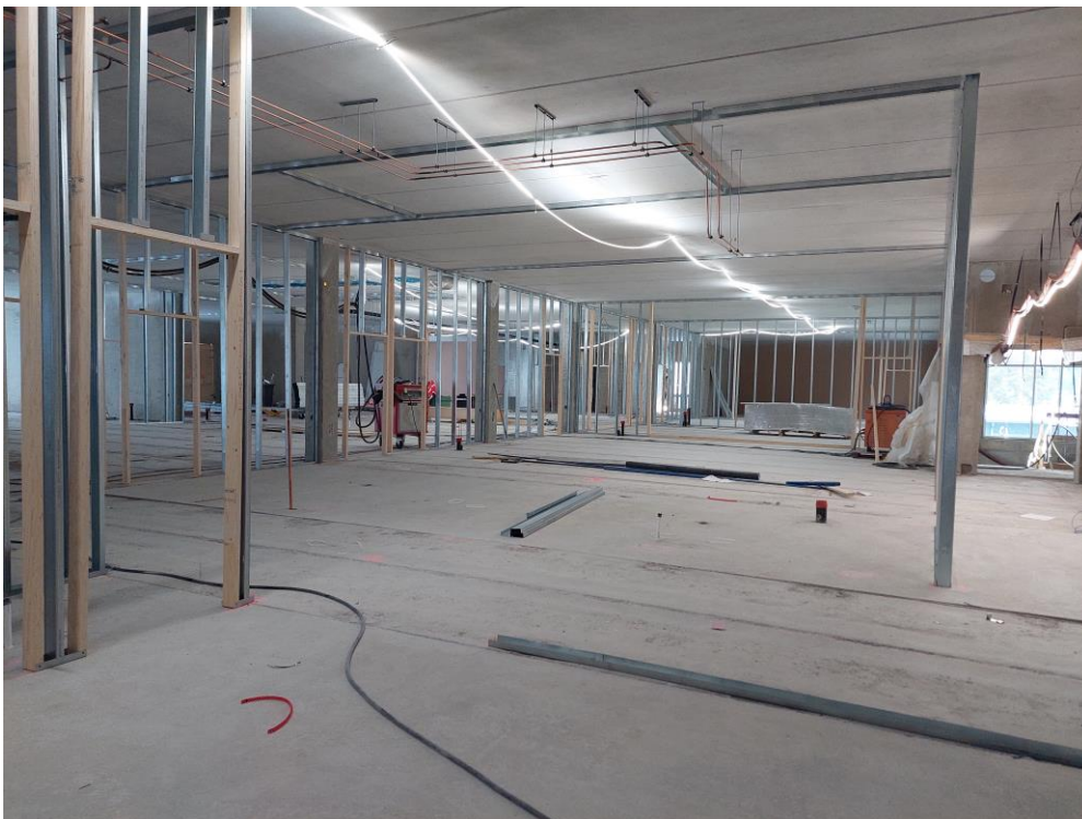
Kuva 9. 3.krs C-lohkolla väliseinätyöt käynnissä.
