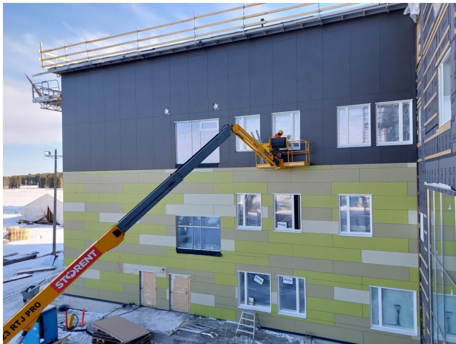
Kuva 4. Julkisivulevytystä pohjoispuolella. Kuvassa käynnissä ikkunapellitykset.
