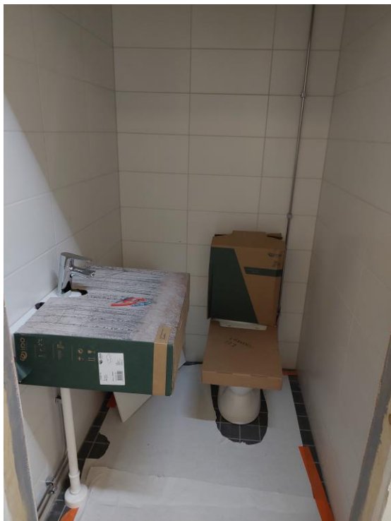
Kuva 10. 1.krs A-lohkolla LVI-kalustus aloitettu.
