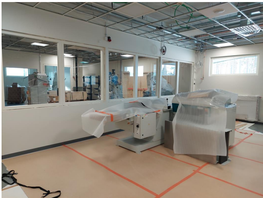
Kuva 6. 1.krs A-lohkolla teknisen työn tilan koneet nostettu sisälle ja asennus aloitettu. Sisäikkunoiden asennus myös aloitettu samalla lohkolla.
