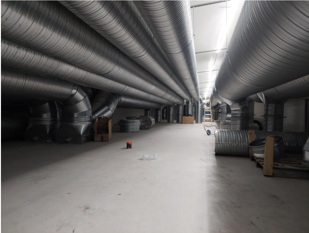
Kuva 8. 4.krs IVKH kanavatilán ilmanvaihtokanavien asennuksia.
