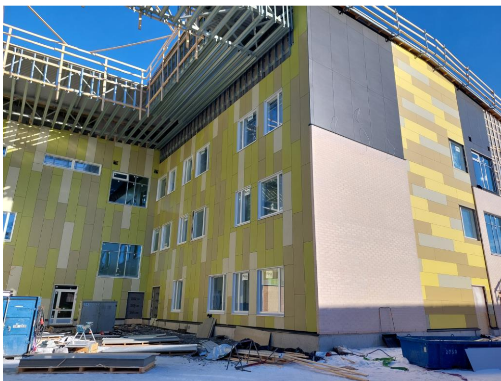
Kuva 3. Julkisivulevytyt etenee pääsisäänkäynnin ja etelän puolen sivulla.
