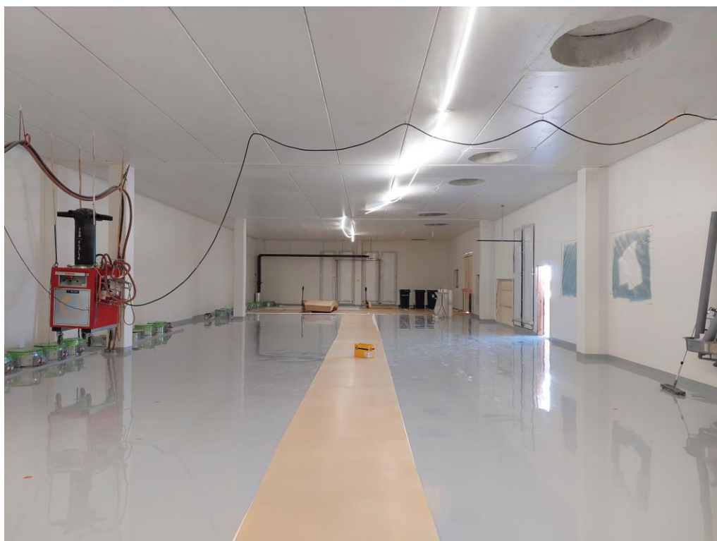
Kuva 7. 4.krs IVKH seinä- ja lattiapinnoitukset tehty sekä suojaukset aloitettu.
