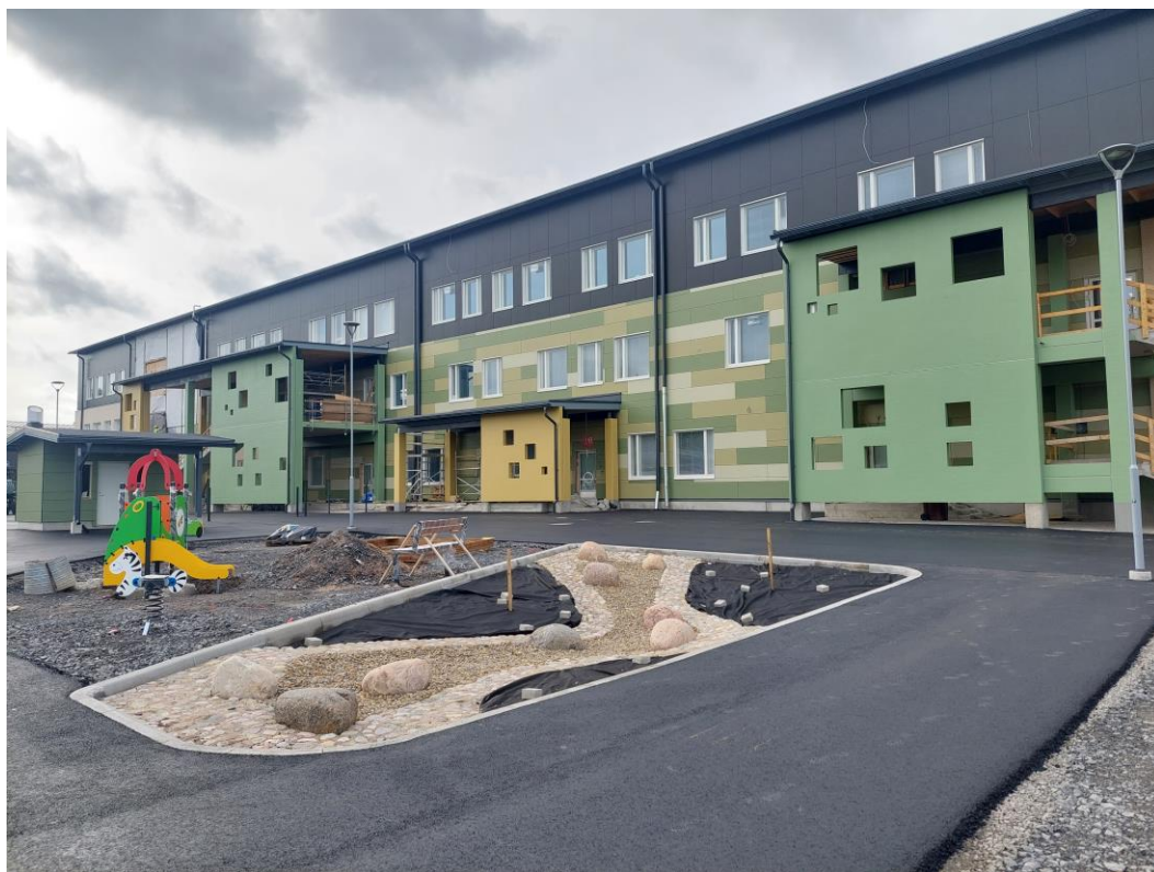
Kuva 2. Julkisivua itään. Pihat on pääosin asfaltoitu, leikkivälineet pääosin asennettu ja piharakennuksista osa on tehty.
