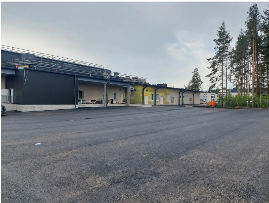
Kuva 12. Keittiön huoltopihan asfaltointi tehty heinäkuussa.
