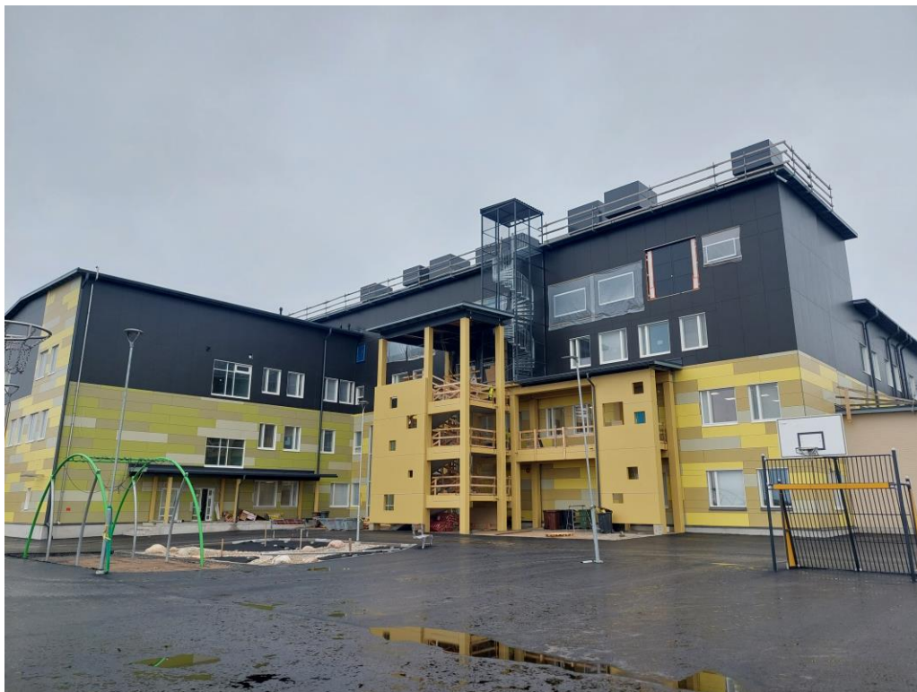
Kuva 4. Rakennuksen pohjoispuolella asfaltointi tehty ja leikkivälineet paikoillaan.
