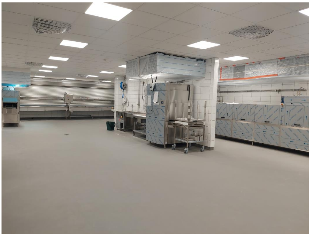
Kuva 5. 1.krs A-lohkolla keittiön loppusiivouksen ensimmäinen vaihe tehty ja alue puhtaustarkastettu toimintakoevaihetta varten.
