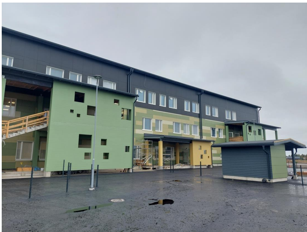
Kuva 3. Julkisivua itään päin.
