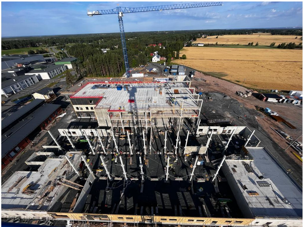
Kuva 2. Työmaatilanne 15.8.2022. Kuvassa C-lohkolla asennettu pilareita ja ulkoseiniä. B-lohkon runko noussut 3.krs asti ja aloiteltu 4.krs IVKH runkotyöt.
