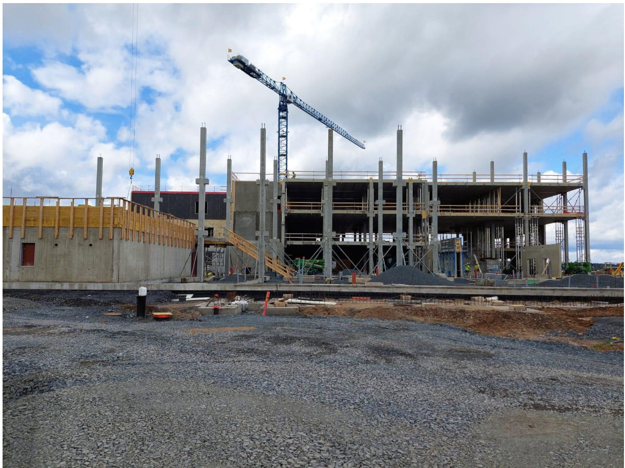
Kuva 5. C-lohkolla väestönsuojat valettu ja 1.krs runkotyöt alkaneet.
