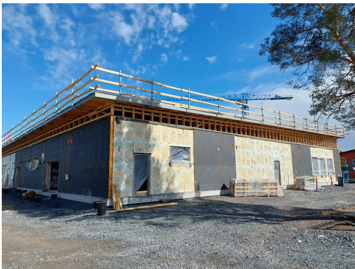
Kuva 3. Vesikattotyöt edennyt A-lohkolla hyvin. Julkisivumuuraus aloitetaan syyskuussa kuvan osiolta.
