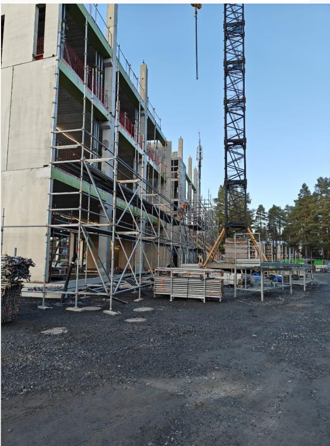
Sääsuojan telineistön pystytys käynnissä
