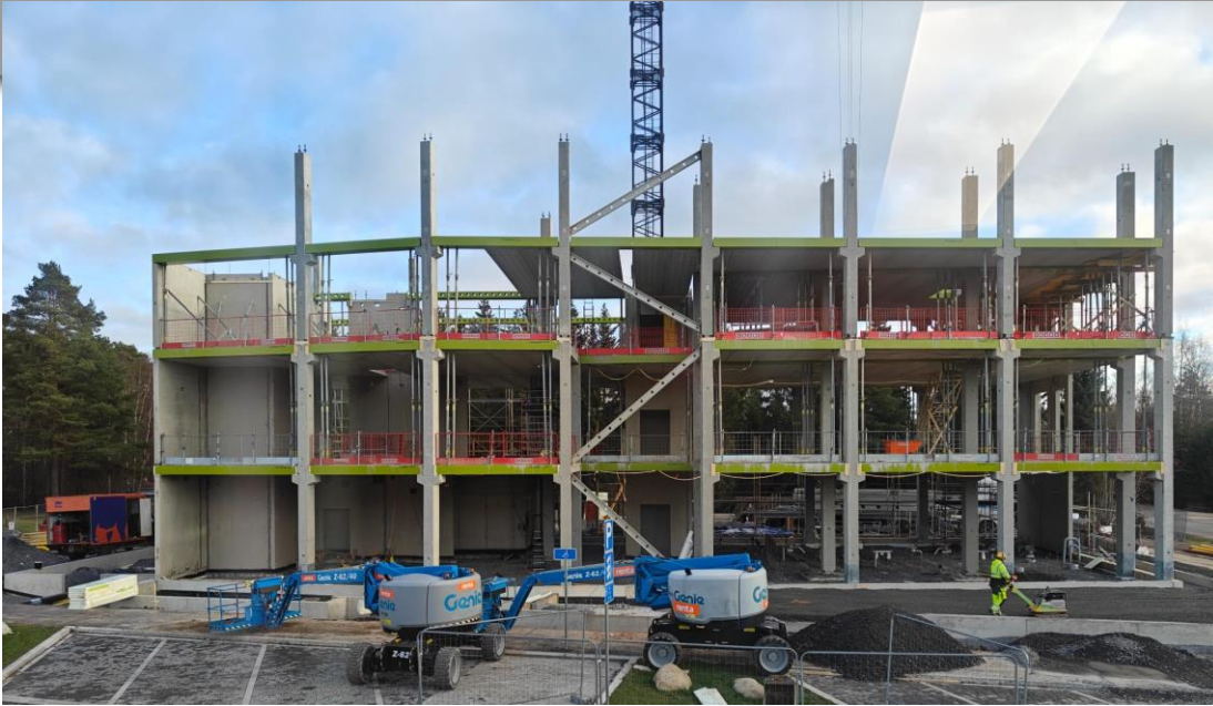
Näkymä hallituskadulta. Rungon teräs jäykisteet asennettuna.
