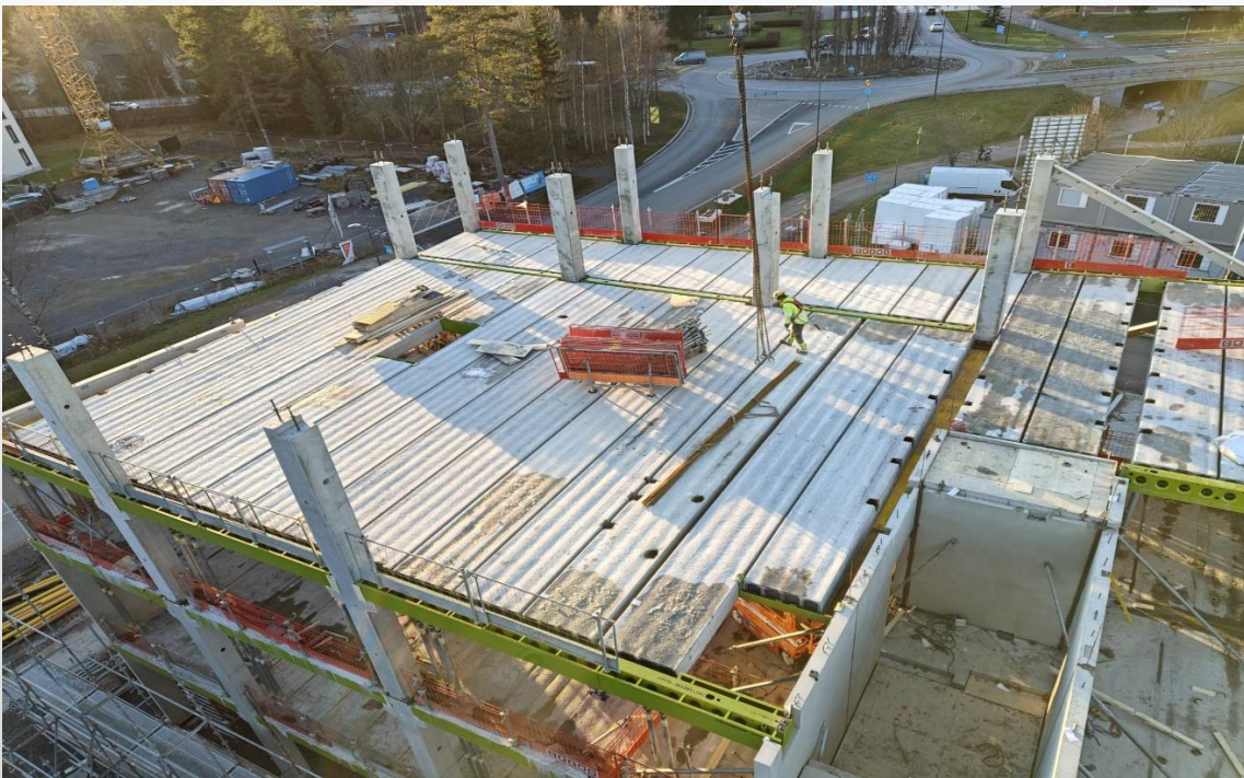
3.krs ontelolaatta asennus
